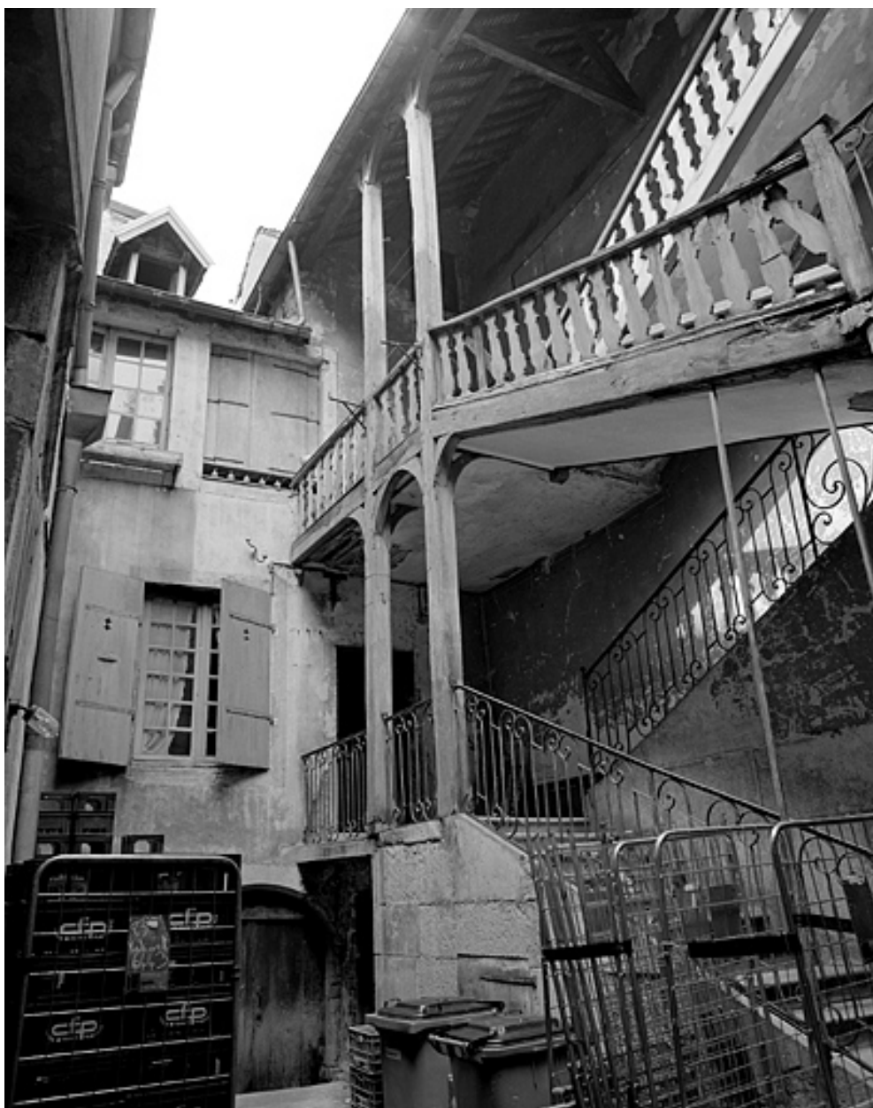
L'escalier s'ouvrant sur la cour.
