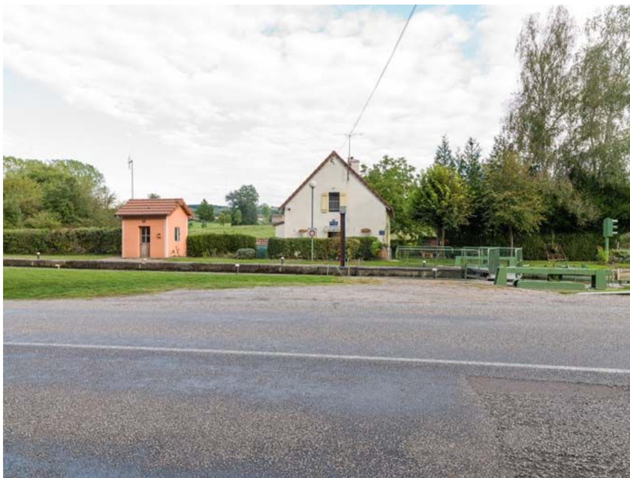
Vue d'ensemble du site d'écluse.
