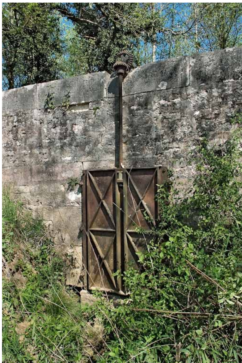
Vanne de l'aqueduc ménagé dans la route-digue.
