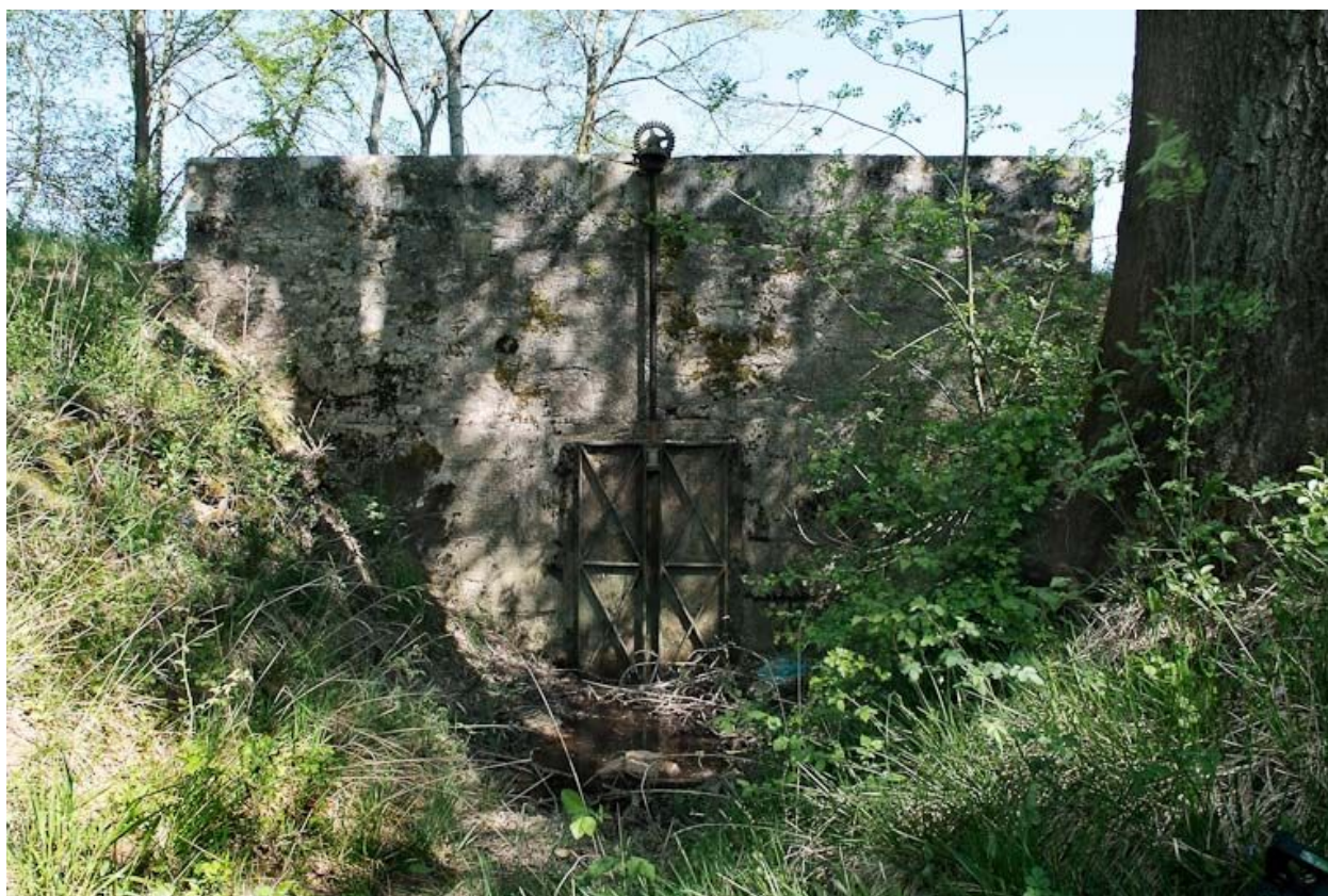
Vanne de l'aqueduc.
