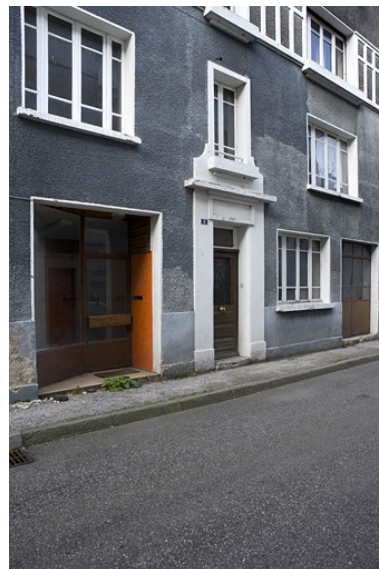
Baies du rez-de-chaussée et du premier étage. Phot. Yves Sancey IVR43_20093900138NUC2A
