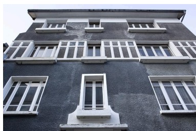
Baies et décor des étages. Phot. Yves Sancey IVR43_20093900139NUC2A
