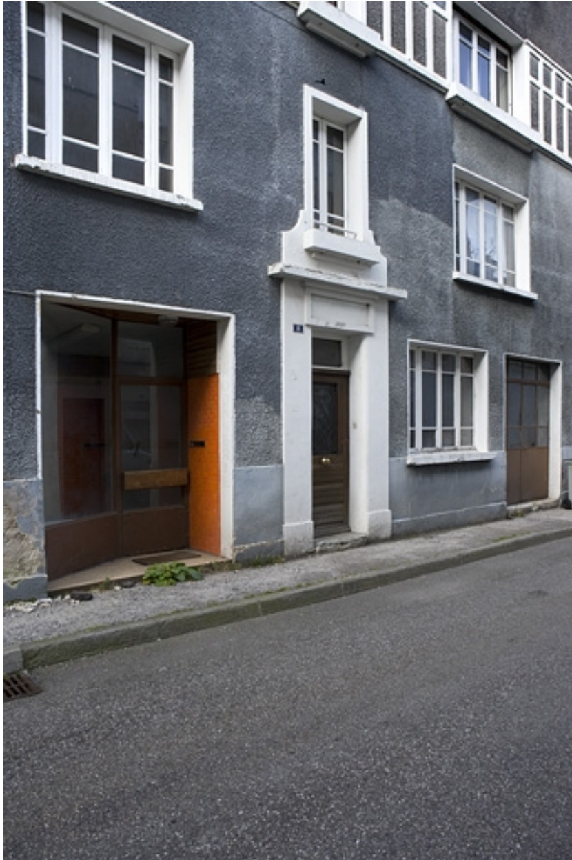
Baies du rez-de-chaussée et du premier étage.
