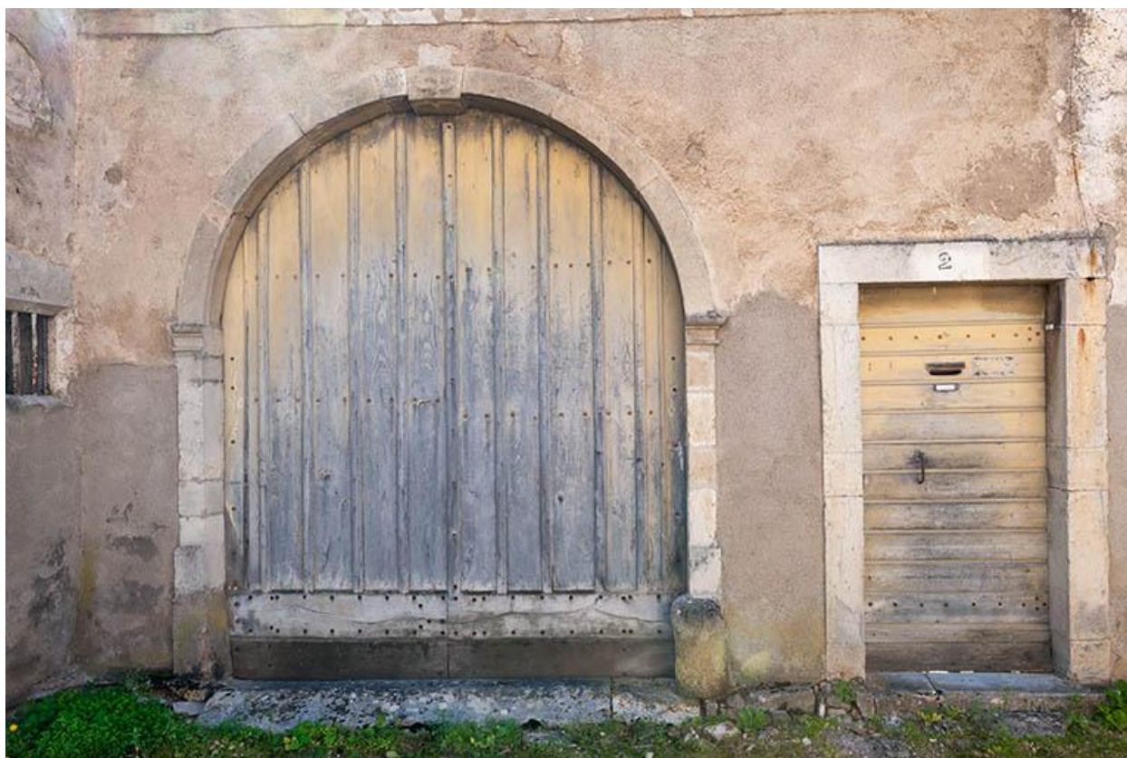
Détail du porche situé rue de l'Eglise
