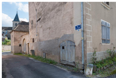
Angle nord-est Phot. Jérôme Mongreville IVR43_20137000347NUCA
