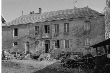
Façade antérieure sur cour.
