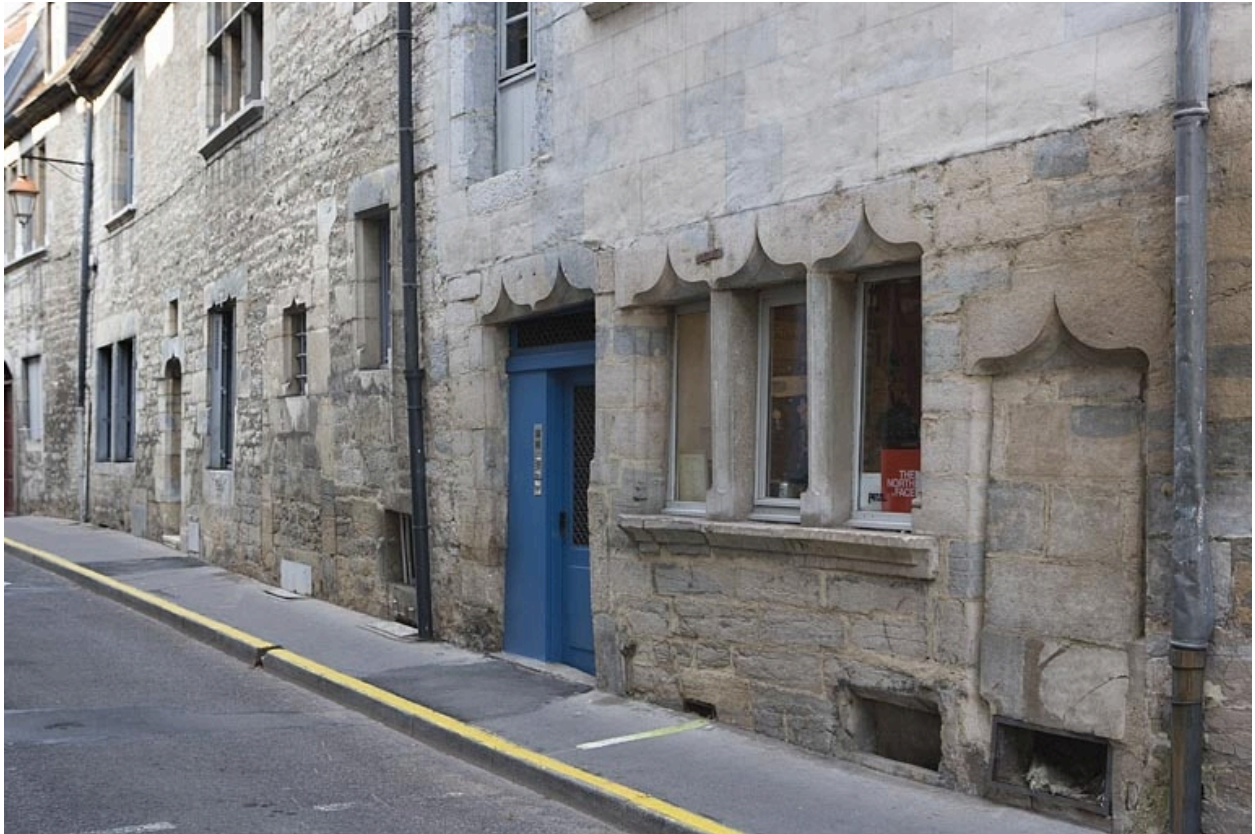
Rue Renan, détail du rez-de-chaussée, de trois quarts droit.
