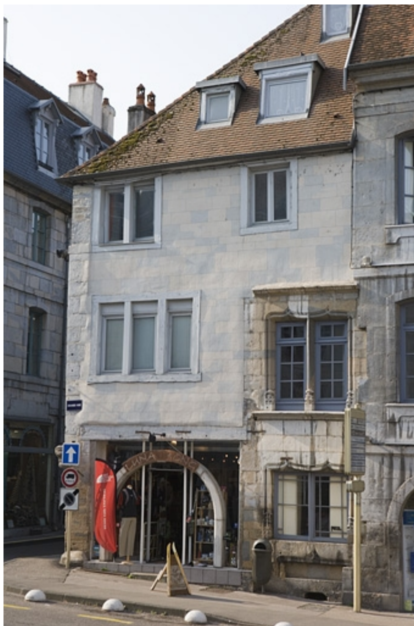
Vue d'ensemble de la façade sur la Grande Rue, de trois quarts droite.
