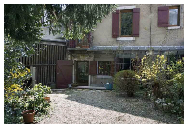
Détail du rez-de-chaussée du logis secondaire situé au fond de la parcelle. Phot. Yves Sancey IVR43_20092501346NUC2A
