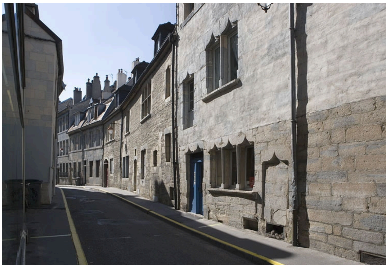
Vue d'ensemble dans l'alignement de la rue Renan.
