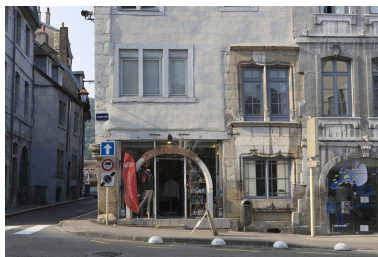
Détail du rez-de-chaussée et du premier étage de la façade sur la Grande Rue. Phot. Yves Sancey IVR43_20092501319NUC2A
