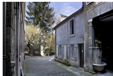
Vue d'ensemble du séchoir avec habitation en rez-de-chaussée, de trois quarts droit. Phot. Yves Sancey IVR43_20092501343NUC2A
