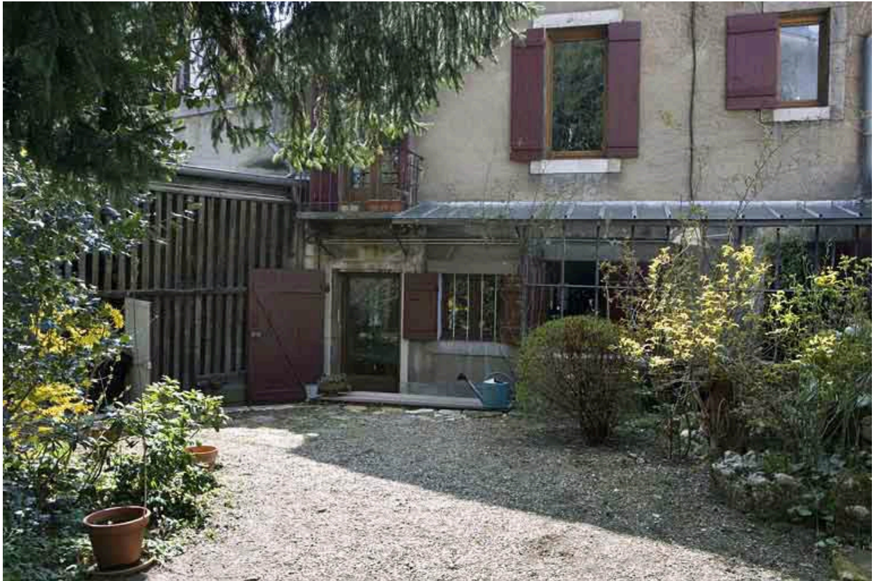
Détail du rez-de-chaussée du logis secondaire situé au fond de la parcelle.
