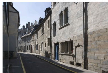
Vue d'ensemble dans l'alignement de la rue Renan. Phot. Yves Sancey IVR43_20092501326NUC2A
