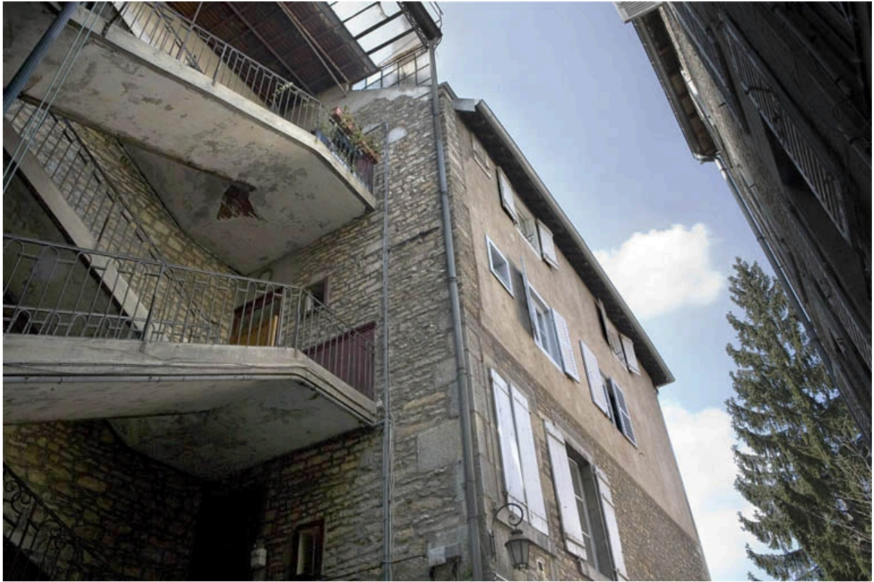
Détail de l'escalier à cage ouverte et de l'aile gauche.
