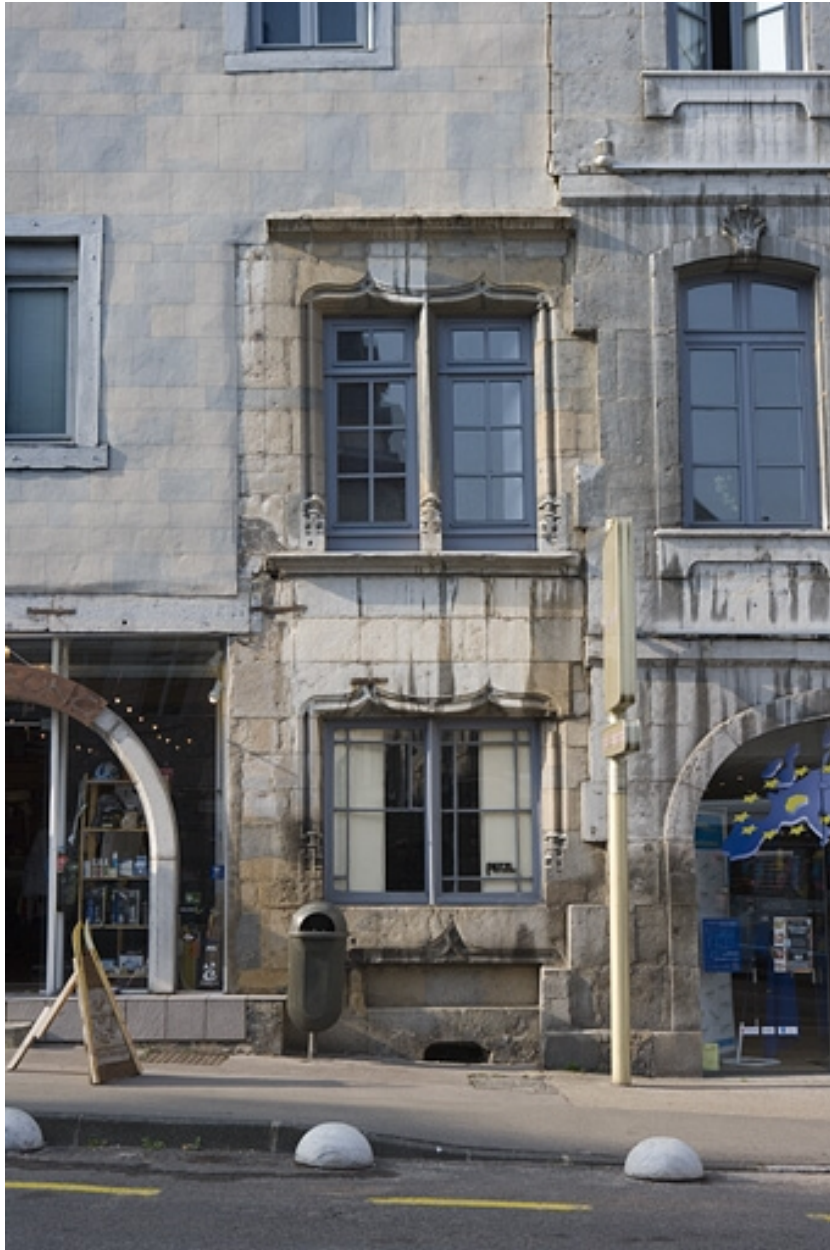
Détail de la partie droite en pierre de la façade sur la Grande Rue.
