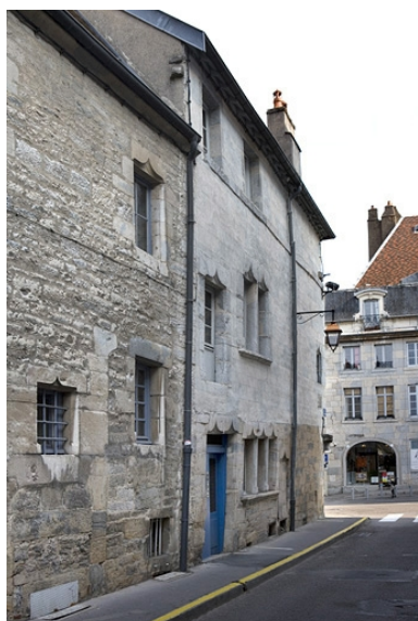
Vue d'ensemble de la façade sur la rue Renan, de trois quarts gauche. Phot. Yves Sancey IVR43_20092501323NUC2A
