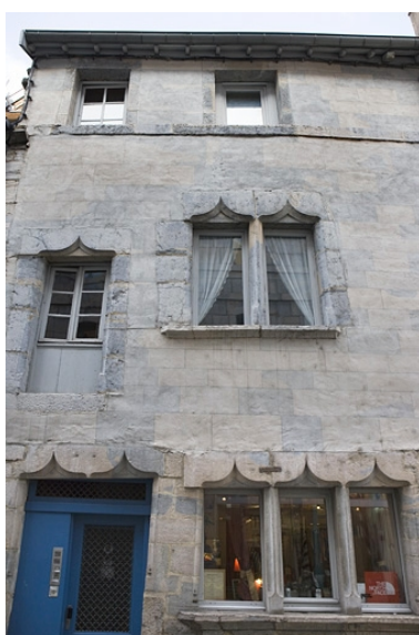
Vue d'ensemble de la façade sur la rue Renan, de face. Phot. Yves Sancey IVR43_20092501322NUC2A
