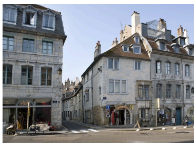
Vue d'ensemble éloignée. Phot. Yves Sancey IVR43_20092501316NUC2A
