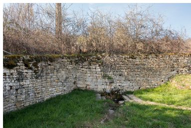
La fontaine dans son contexte. Phot. Nicolas Waltefaugle IVR26_20268900140NUC4A
