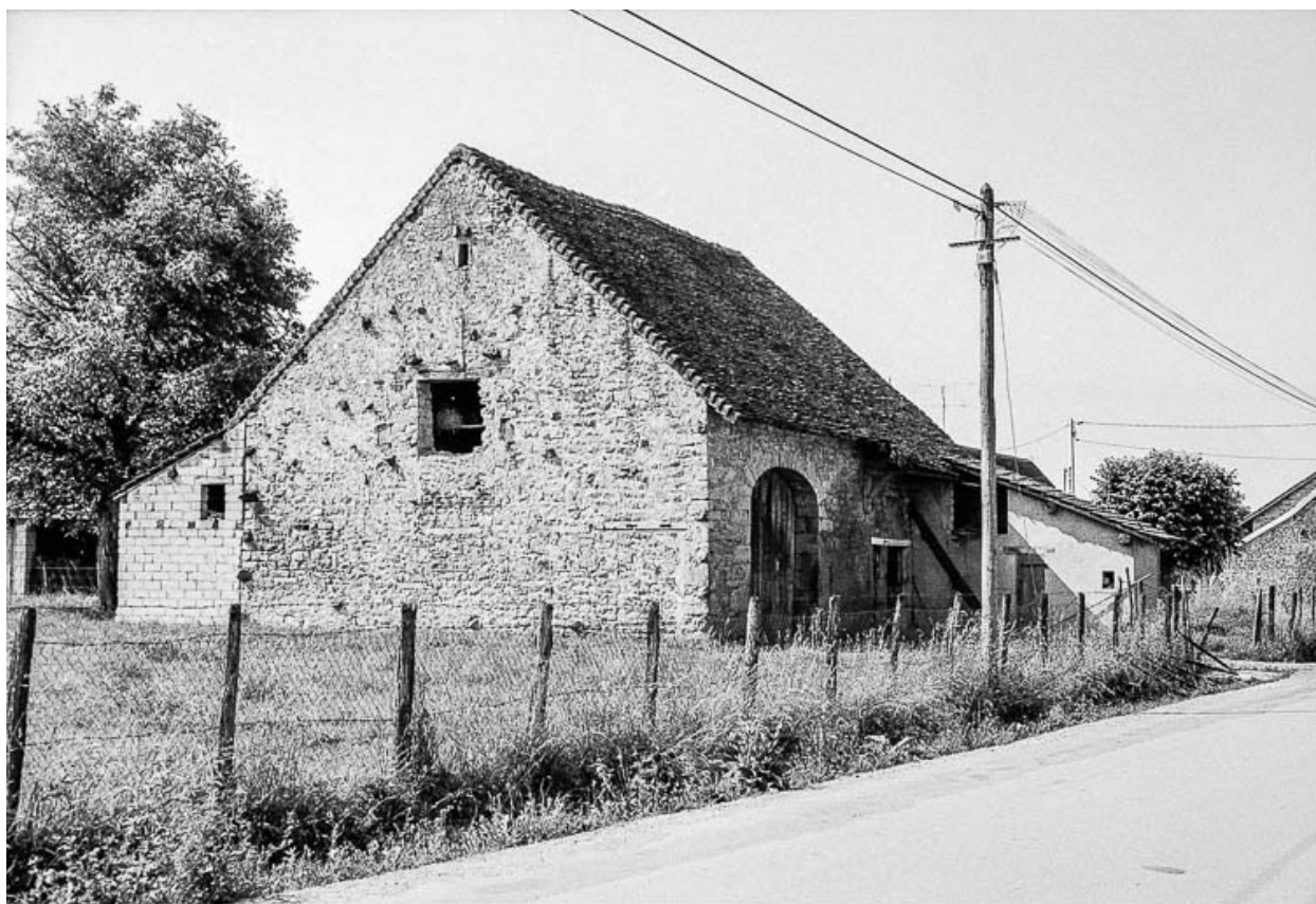
Ferme cadastrée 1984 B 552 : vue d'ensemble.
