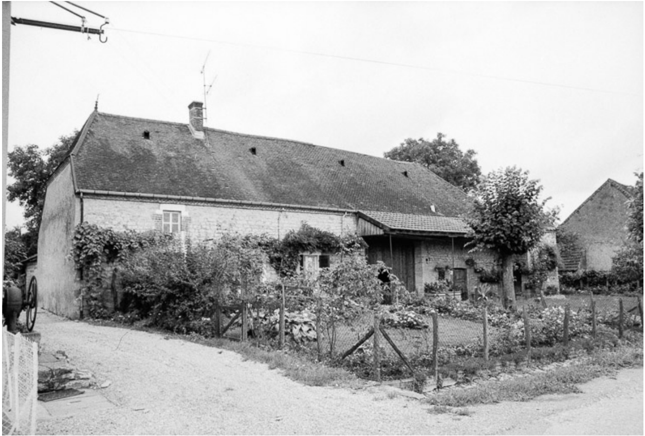
Ferme cadastrée 1984 B 84 : façade antérieure. Vue générale.
