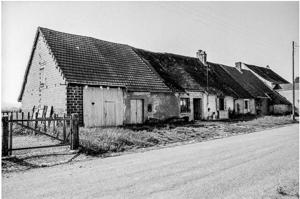
Ferme cadastrée 1984 B2 569-570 : vue d'ensemble.
