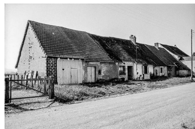
Ferme cadastrée 1984 B2 569-570 : vue d'ensemble. Phot. Yves Sancey IVR43_19753900486Z
