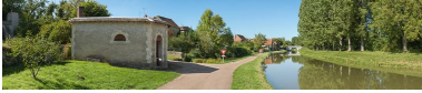
Vue d'ensemble du lavoir, avec l'allée de peupliers sur la rive droite. Phot. Pierre-Marie Barbe-Richaud IVR26_20135800444NUC4AQ
