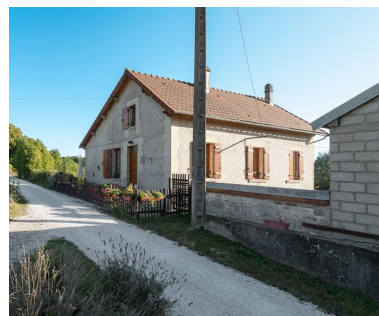
Vue de 3/4. Phot. Pierre-Marie Barbe-Richaud IVR26_20128900508NUC2AQ
