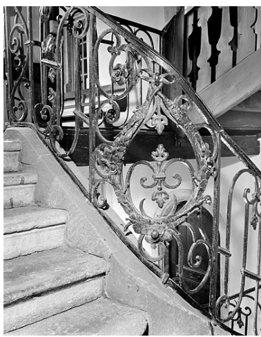
Détail d'un panneau. Phot. Jérôme Mongreville IVR43_19872500336X
