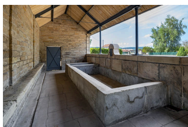
L'intérieur du lavoir, depuis le côté gauche. Phot. Jérôme Mongreville IVR43_20217000498NUC4A
