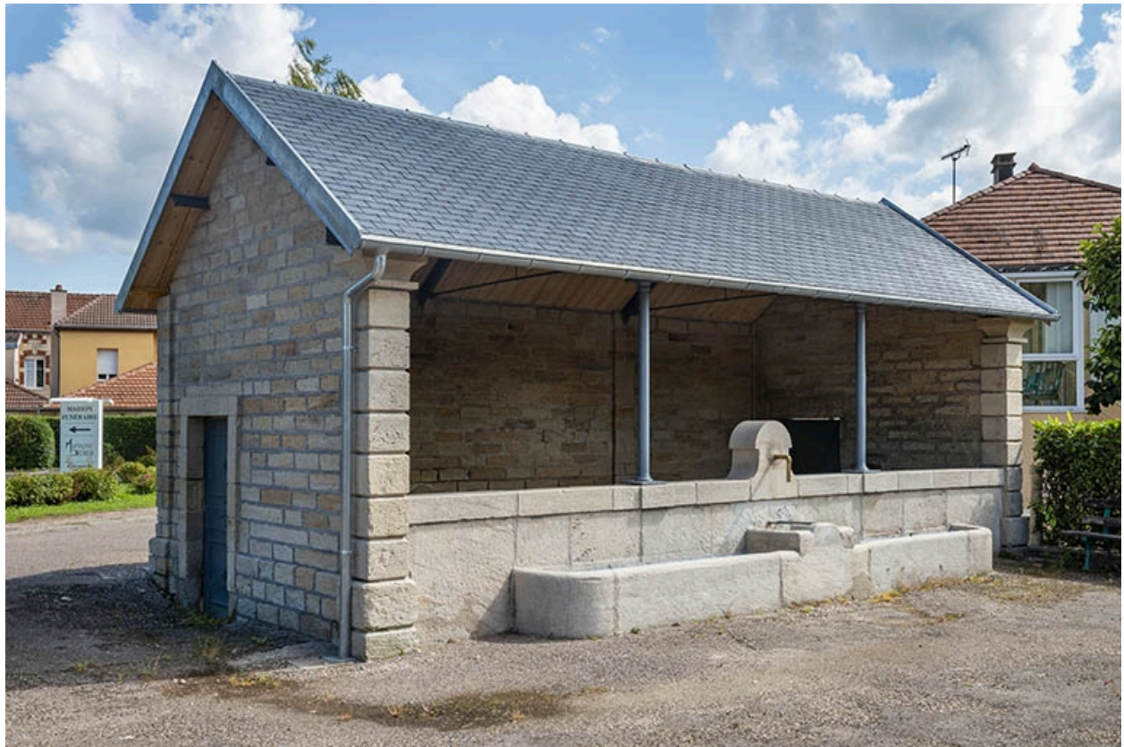
Trois quarts avant gauche du lavoir.
