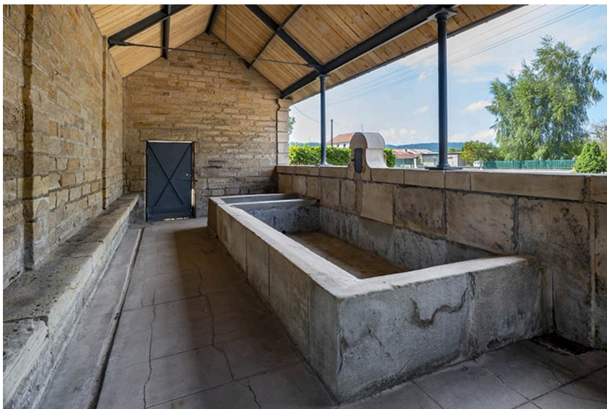
L'intérieur du lavoir, depuis le côté gauche.
