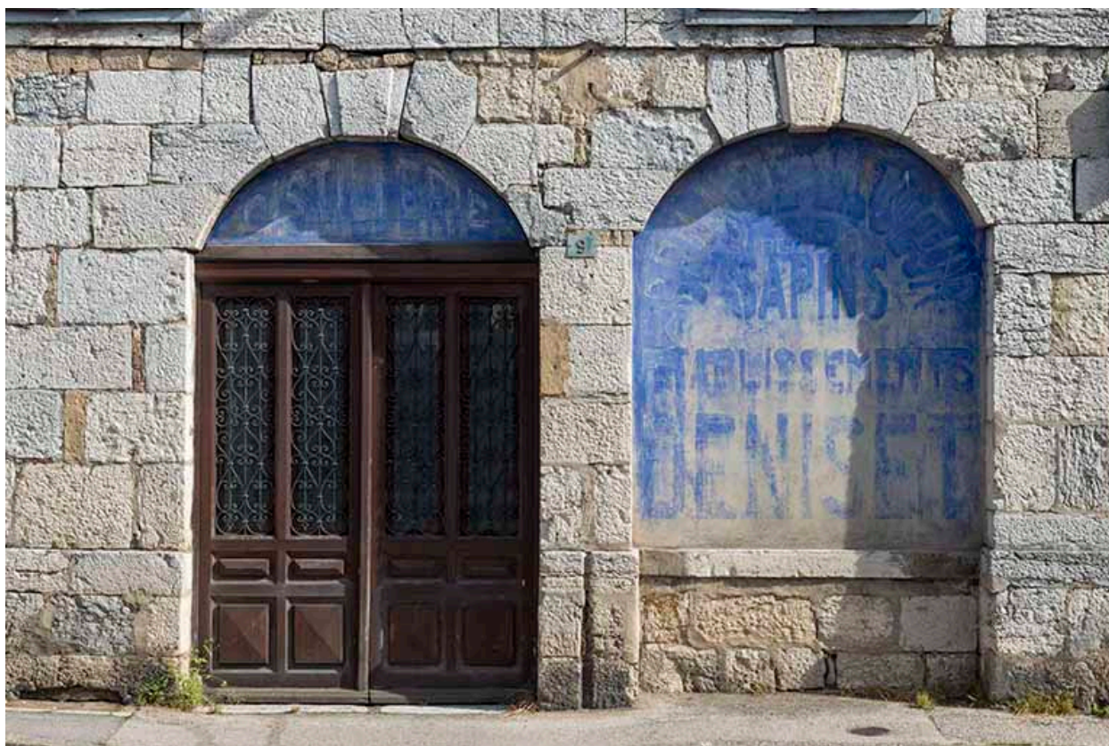
Détail de la façade ouest.
