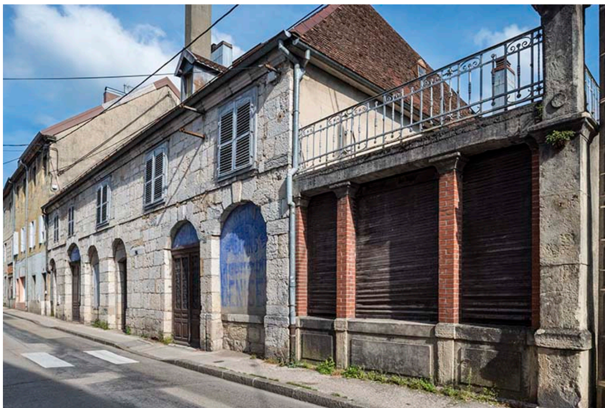
Vue rapprochée depuis le sud-ouest.
