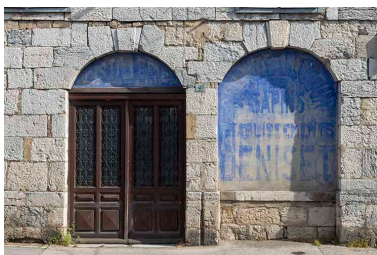
Détail de la façade ouest. Phot. Jérôme Mongreville IVR43_20162501200NUC4A
