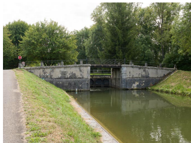
Vue d'ensemble du pont.
