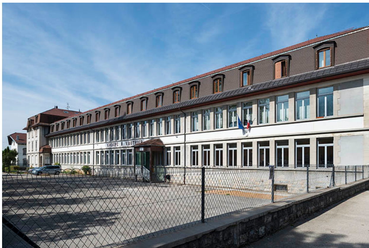
Façade sud vue de trois quarts droite.
