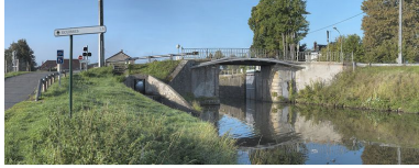
Le site d'écluse 05 vu du bief 06. Pont sur écluse avec escalier. Arrivée de la rigole régulatrice des biefs. Phot. Thierry Kuntz IVR26_20127100370NUC4AQ
