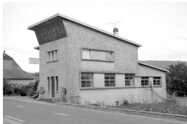
Fromagerie vue de trois quarts droite. Phot. Laurent Poupard IVR43_19923901281Z
