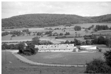
Porcherie vue du nord-ouest. Phot. Laurent Poupard IVR43_19923901286Z
