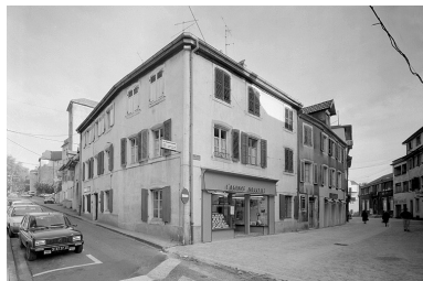
Vue d'ensemble. Phot. Jérôme Mongreville IVR43_19872501166V
