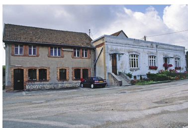
Bureau et logement. Phot. Yves Sancey IVR43_20009000053ZA
