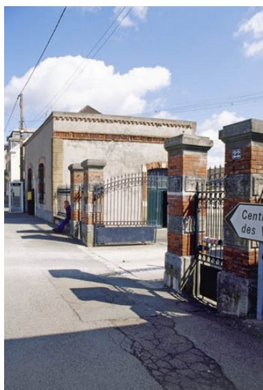
Grille d'entrée. Phot. Yves Sancey IVR43_20009000049ZA
