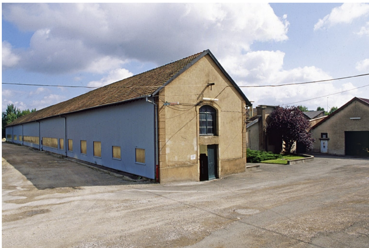
Atelier de fabrication (câblerie).
