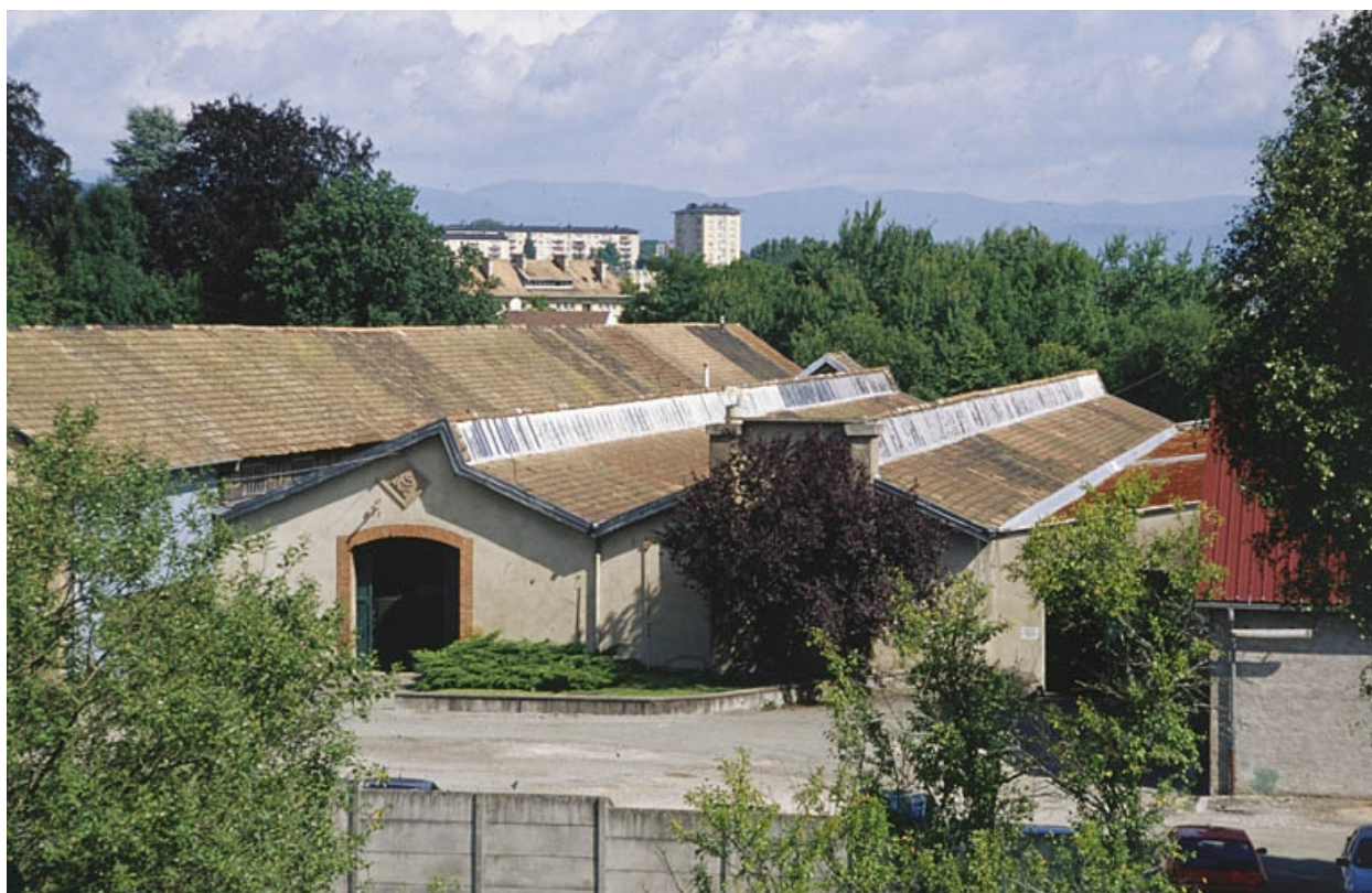
Ateliers de fabrication depuis le sud.
