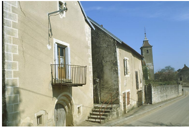
Maison située Grande Rue. Phot. Yves Sancey IVR43_19827000502XA
