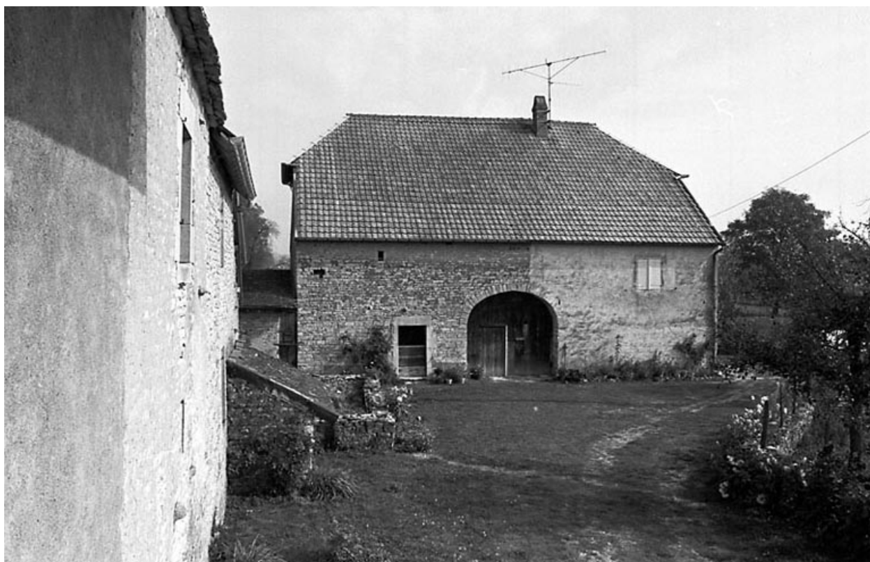
Ferme située place de la Mairie.
