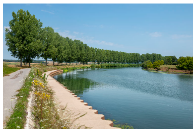
Vue vers l'amont depuis l'entrée du canal. Phot. Jérôme Mongreville IVR43_20207000221NUC4A
