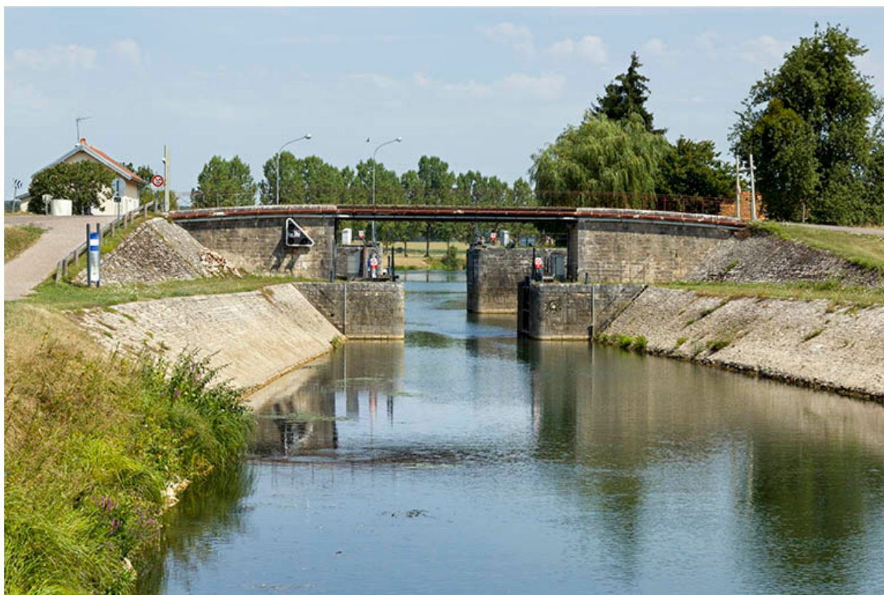
Entrée aval de l'écluse.
