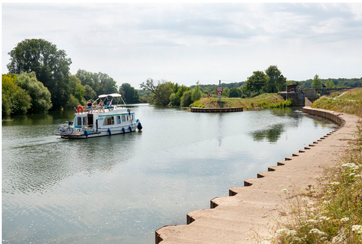
Entrée du canal de navigation de Cubry.
