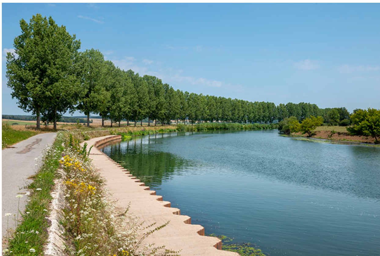
Vue vers l'amont depuis l'entrée du canal.
