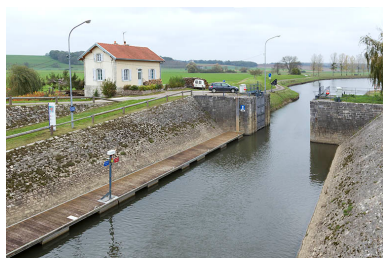
Les perrés inclinés de l'écluse de garde. Phot. Sonia Dourlot IVR43_20157000805NUC2A
