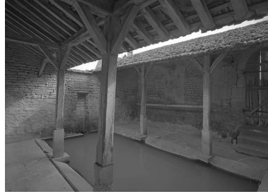
Vue intérieure. Bassin et charpente. Phot. Michel Thierry IVR26_19748900144V
