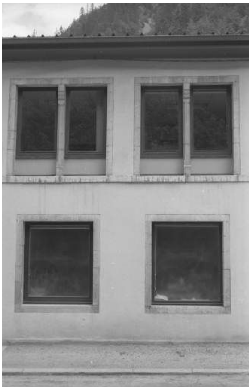
Fenêtres de l'atelier de fabrication des années 1850.
