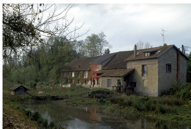
Vue d'ensemble, depuis le nord. Phot. Laurent Poupard IVR43_19883900576ZA
