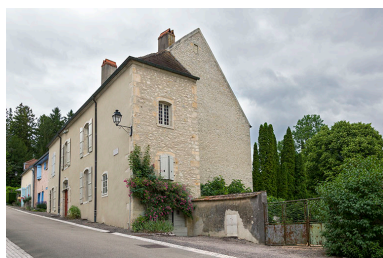
Vue générale depuis la rue du Château. Phot. Sonia Dourlot IVR43_20157000419NUC2A
