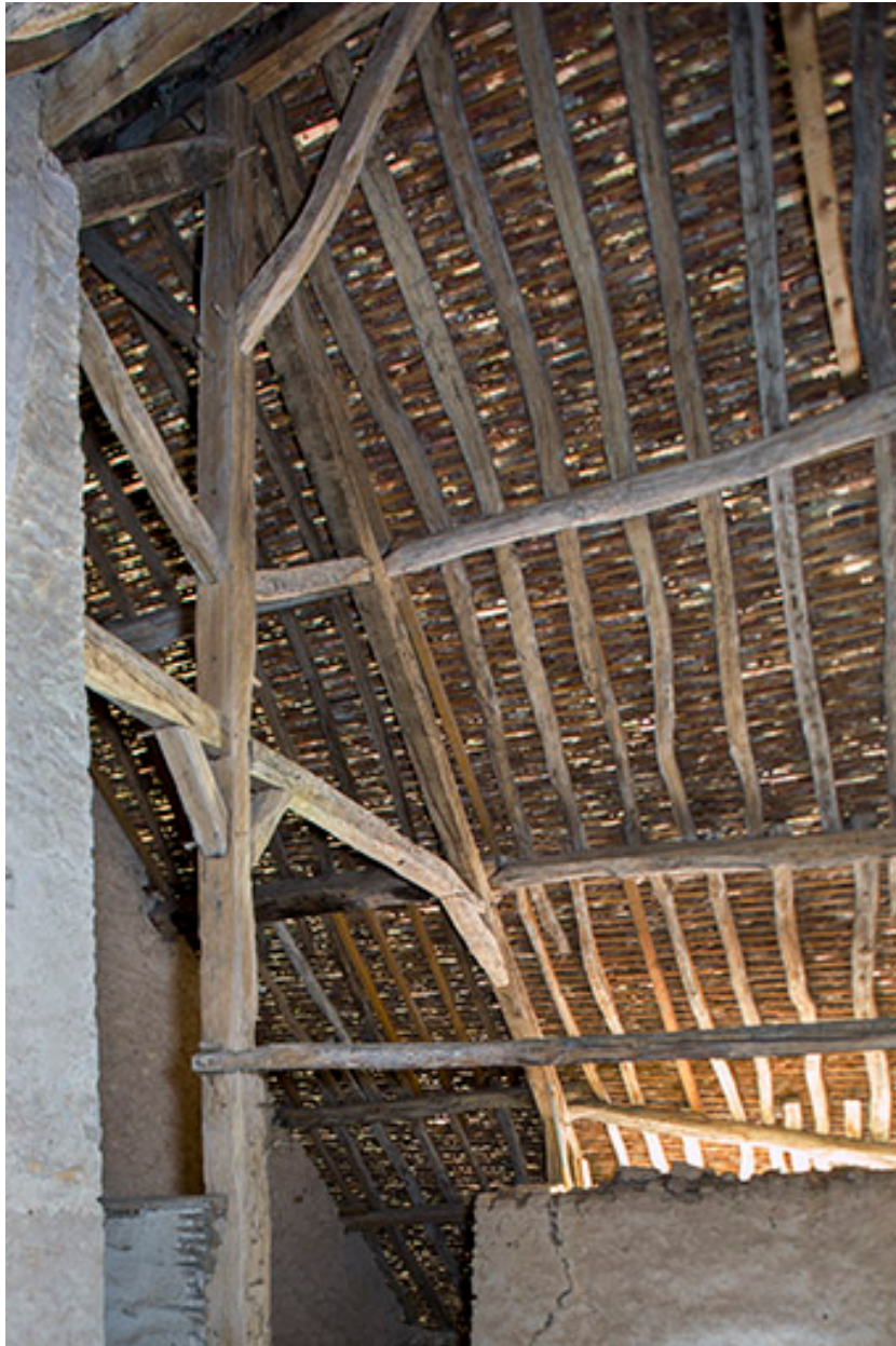
Intérieur : détail de la charpente.
