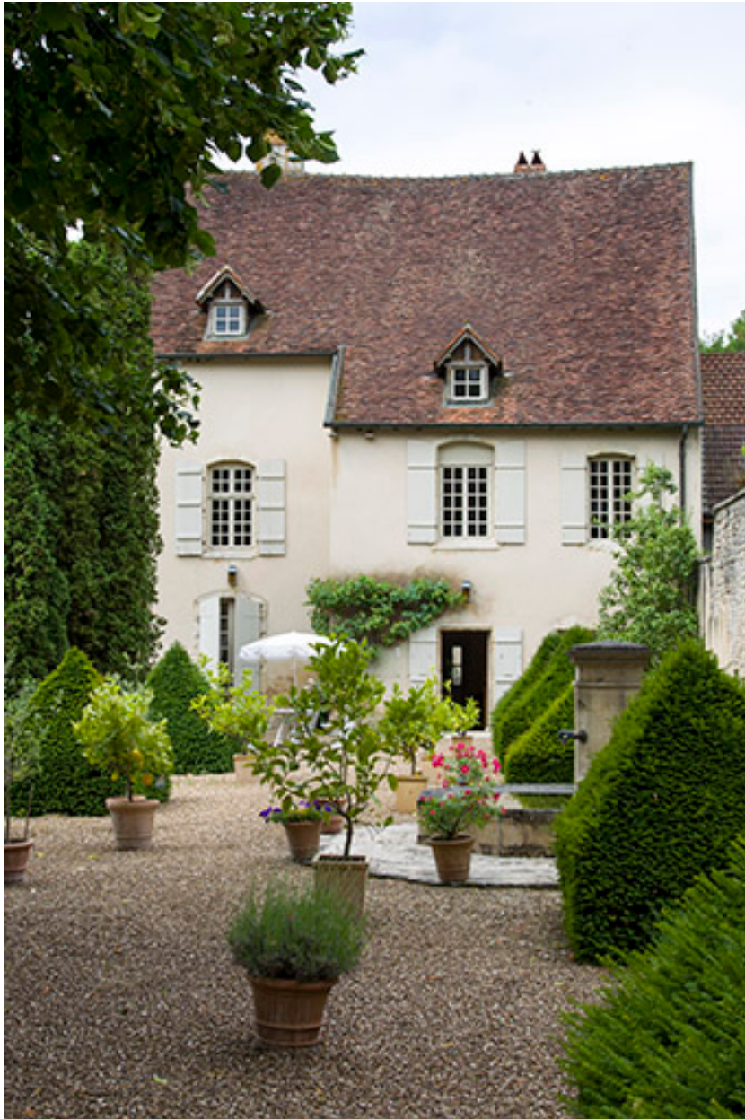
Façade postérieure donnant sur le jardin.
