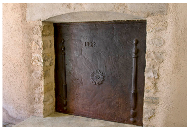
Plaque de cheminée portant la date 1823. Phot. Sonia Dourlot IVR43_20157000423NUC2A
