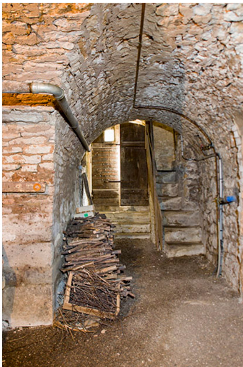
Intérieur : le sous-sol couvert d'une voûte en berceau.
