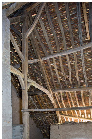
Intérieur : détail de la charpente. Phot. Sonia Dourlot IVR43_20157000427NUC2A
