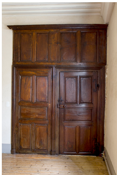
Intérieur : portes de placard et porte de communication. Phot. Sonia Dourlot IVR43_20157000428NUC2A
