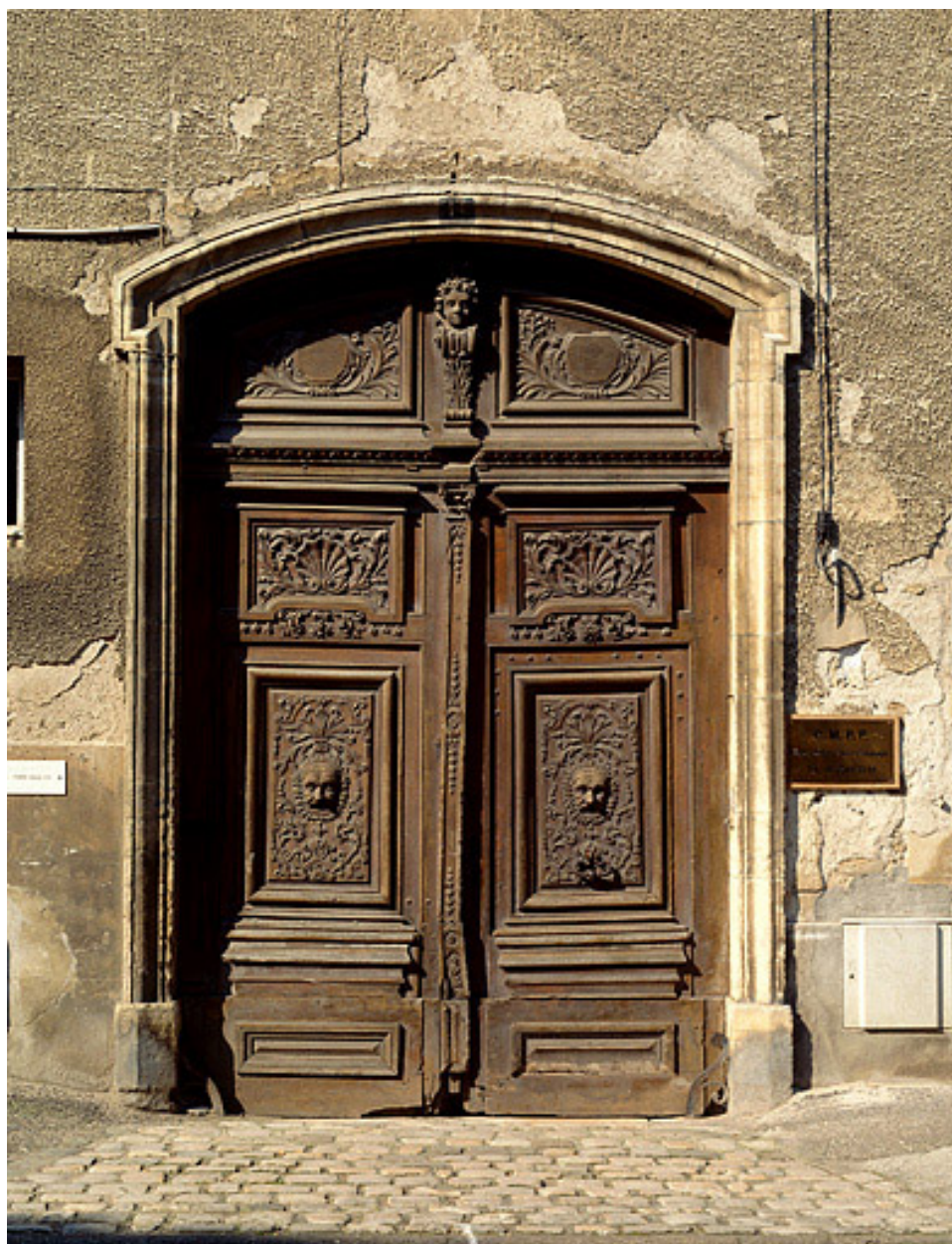
Détail de la porte d'entrée.
