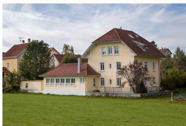
Vue d'ensemble, depuis le nord (façades postérieure et latérale gauche). Phot. Yves Sancey IVR43_20122502238NUC2A
