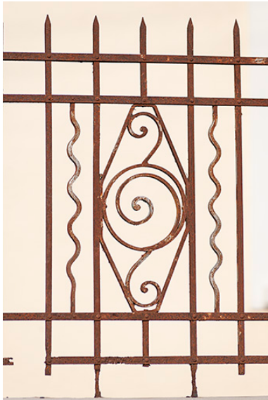
Motif de la grille de clôture. Phot. Jérôme Mongreville IVR43_20142500196NUC4A
