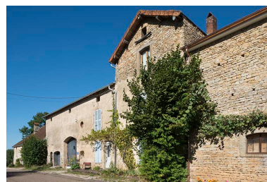
La façade antérieure. Phot. Jérôme Mongreville IVR43_20187000108NUC4A
