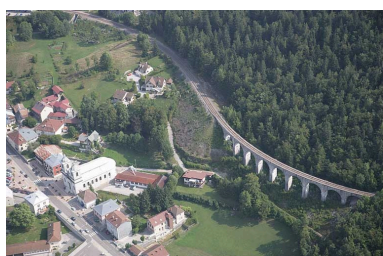
Vue aérienne, depuis le sud-ouest. Phot. Jean-Pierre Bévalot IVR43_20053900993NUCA
