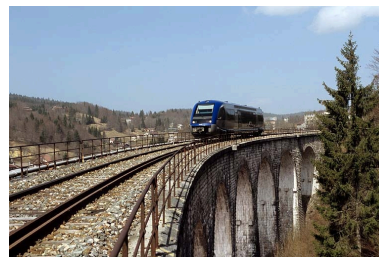
Élévation orientale vue en enfilade depuis le côté La Cluse, avec autorail X 73500 (cadrage horizontal). Phot. Yves Sancey IVR43_20053900328ZA
