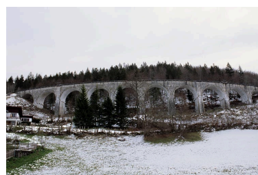
Vue d'ensemble depuis l'ouest, en hiver. Phot. Yves Sancey IVR43_20053900321ZA
