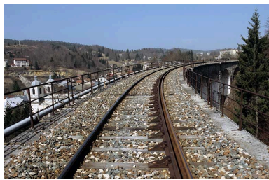
Vue d'ensemble du tablier et des garde-corps, depuis le côté La Cluse. Phot. Yves Sancey IVR43_20053900324ZA
