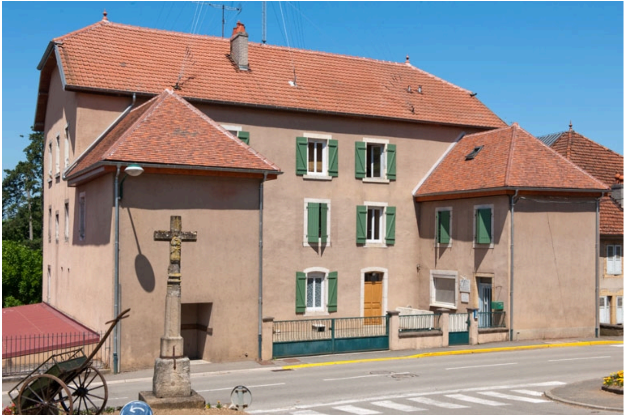
Vue générale rapprochée de trois quart gauche.
