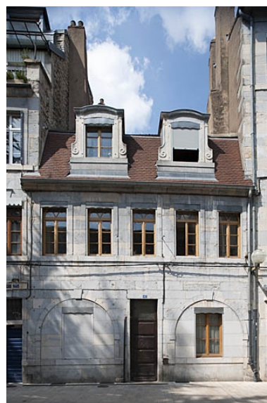
Façade antérieure : vue d'ensemble de face. Phot. Jérôme Mongreville IVR43_20112500045NUC4A
