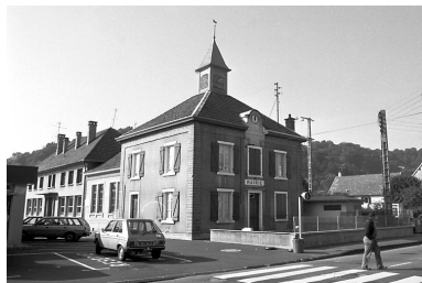
Vue d'ensemble. Phot. Bernard Lardière IVR43_19832500065Z
