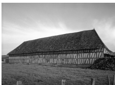
Bâtiment des dépendances, façade postérieure Phot. Michel Rosso IVR26_19867100227V
