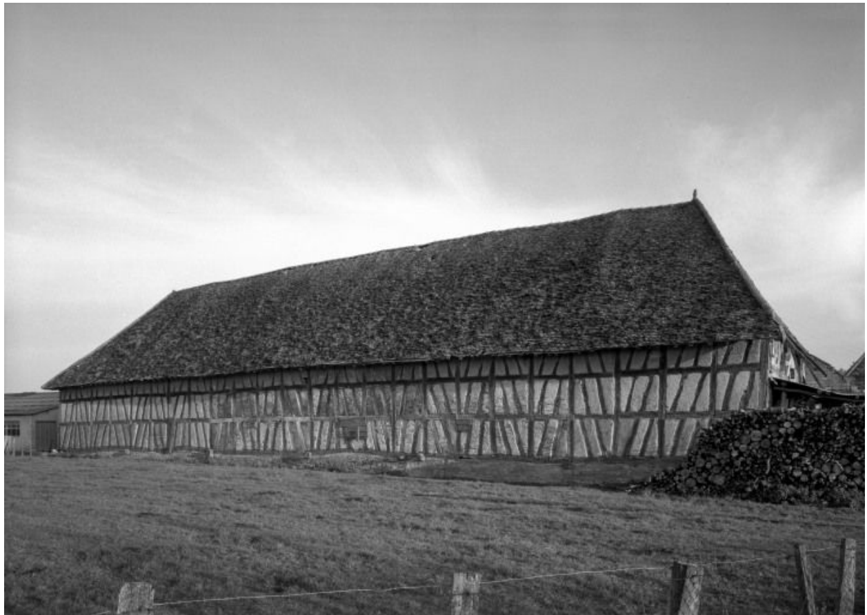
Bâtiment des dépendances, façade postérieure
