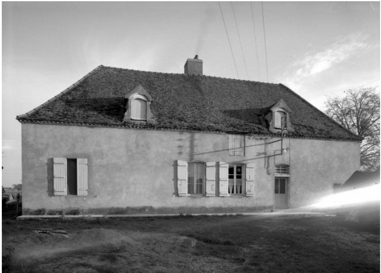
Bâtiment d'habitation, façade antérieure
