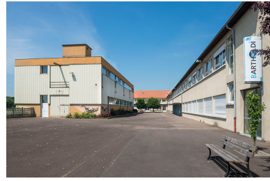
Vue de l'entrée depuis l'est. Phot. Mary Ruffinoni IVR43_20147000099NUC4A
