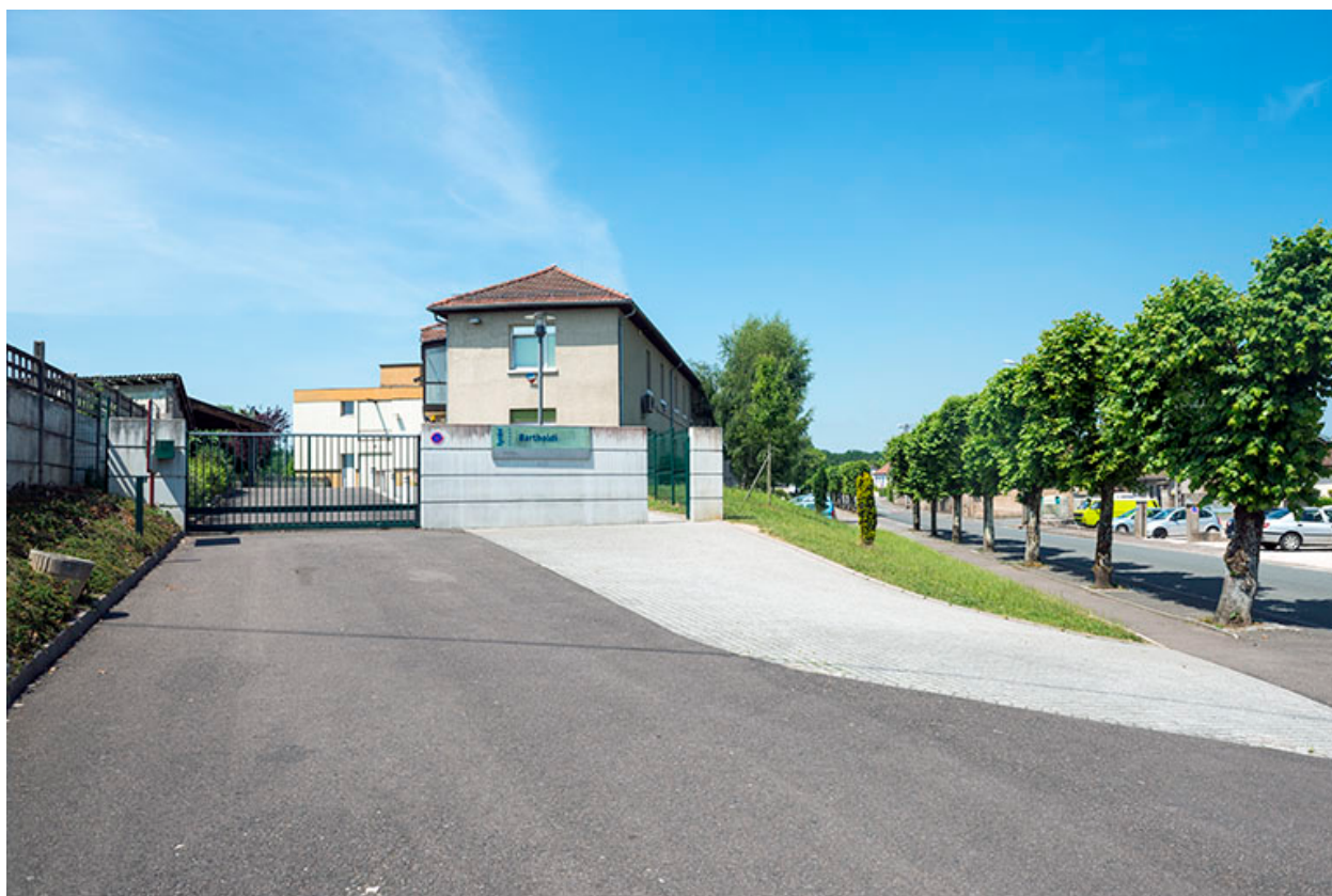
Entrée du lycée.
