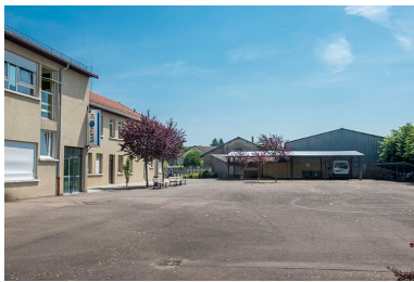
Partie est de la cour. Phot. Mary Ruffinoni IVR43_20147000106NUC4A
