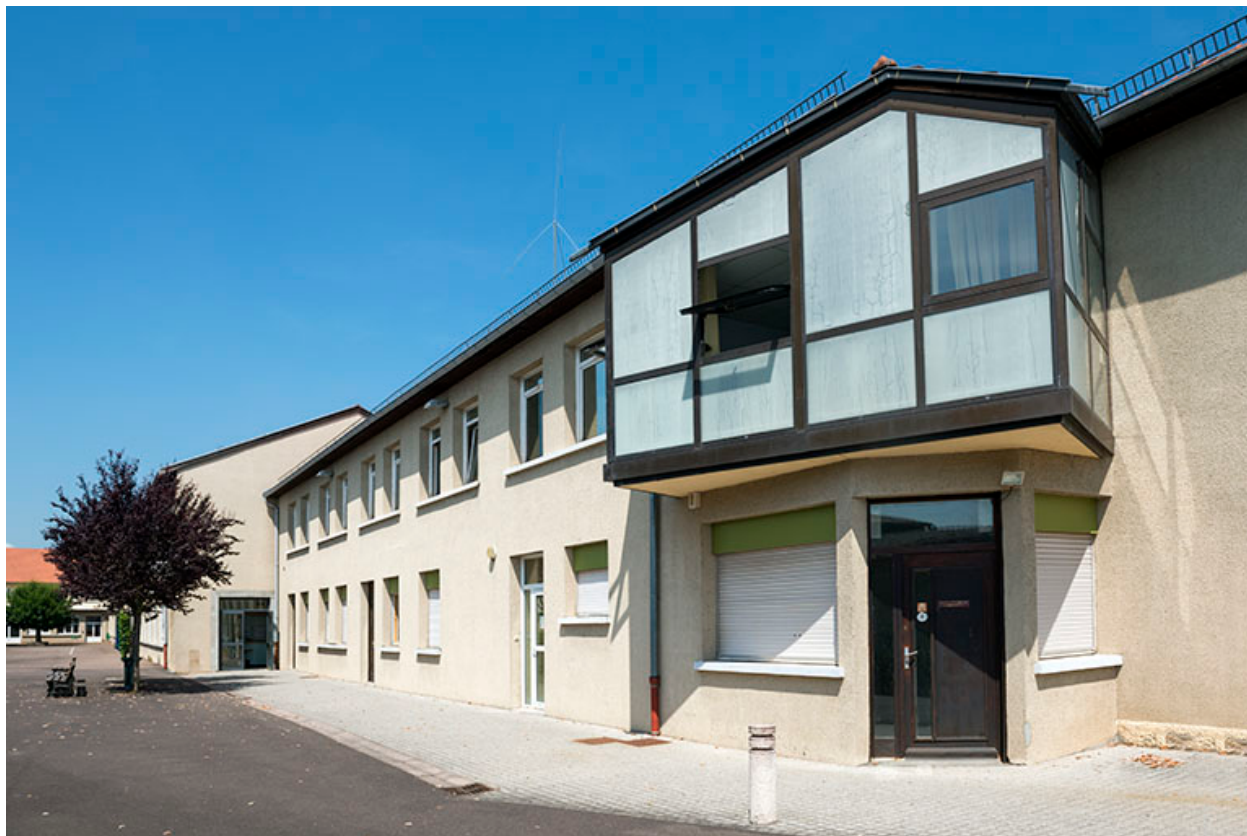
Angle sud-ouest à l'entrée de la cour.
