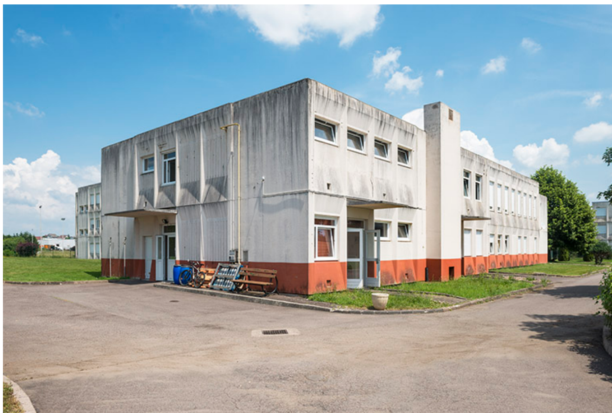
Angle sud-ouest de la restauration.
