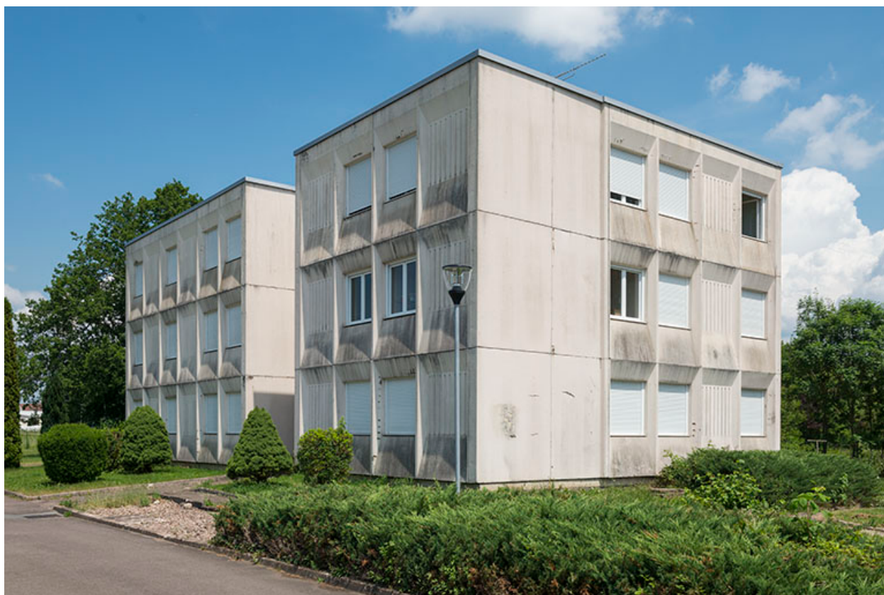
Angle sud-ouest des logements de fonction.
