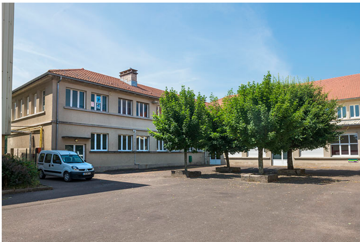
Angle sud-ouest de la cour.
