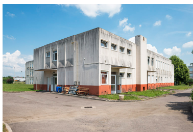
Angle sud-ouest de la restauration. Phot. Mary Ruffinoni IVR43_20147000118NUC4A
