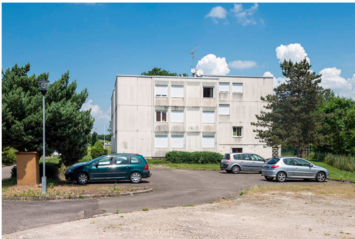
Façade sud des logements.
