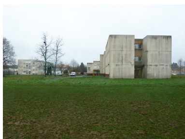
Façade nord de l'internat. Phot. Philippe Mairot IVR43_20147000125NUC4A
