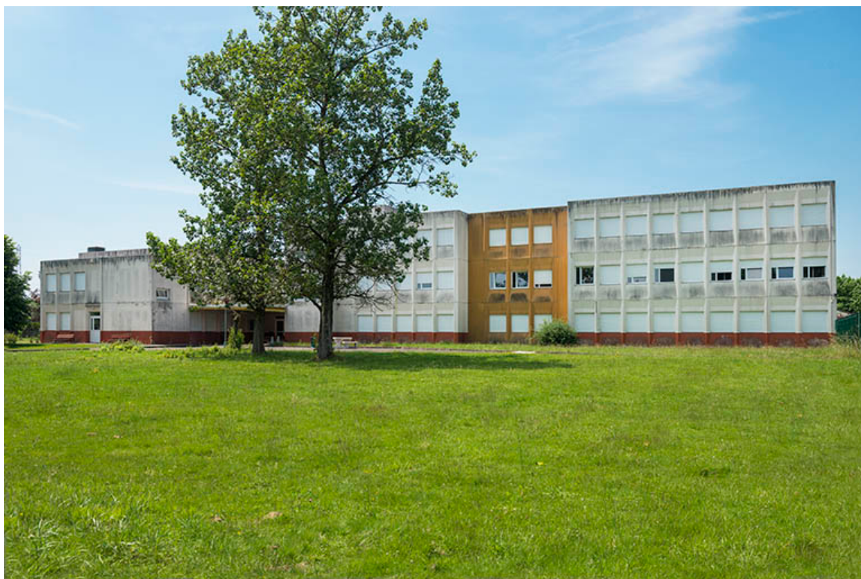
Façade orientale de la restauration.
