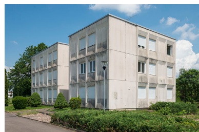
Angle sud-ouest des logements de fonction. Phot. Mary Ruffinoni IVR43_20147000117NUC4A
