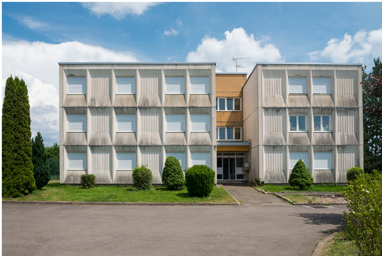
Façade ouest d'entrée des logements de fonction.
