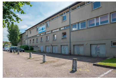
Façade nord rue de Bourdieu. Phot. Mary Ruffinoni IVR43_20147000109NUC4A
