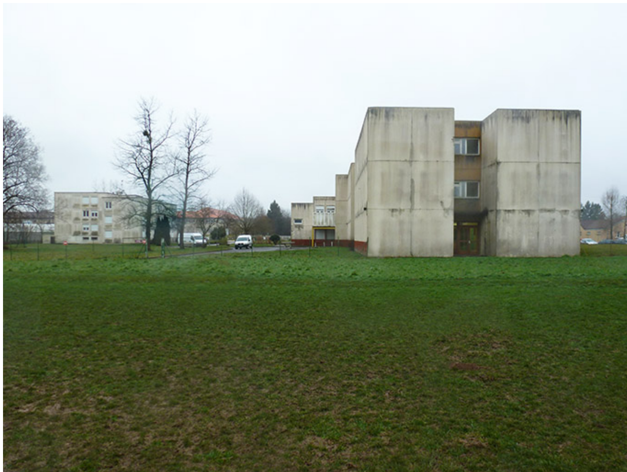
Façade nord de l'internat.
