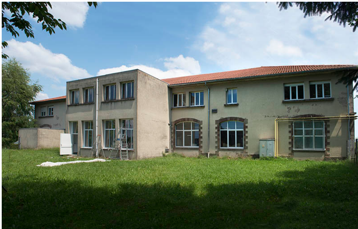
Façade ouest de l'externat atelier.
