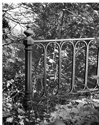
Garde-corps : détail d'un potelet. Phot. Yves Sancey IVR43_20050100007X
