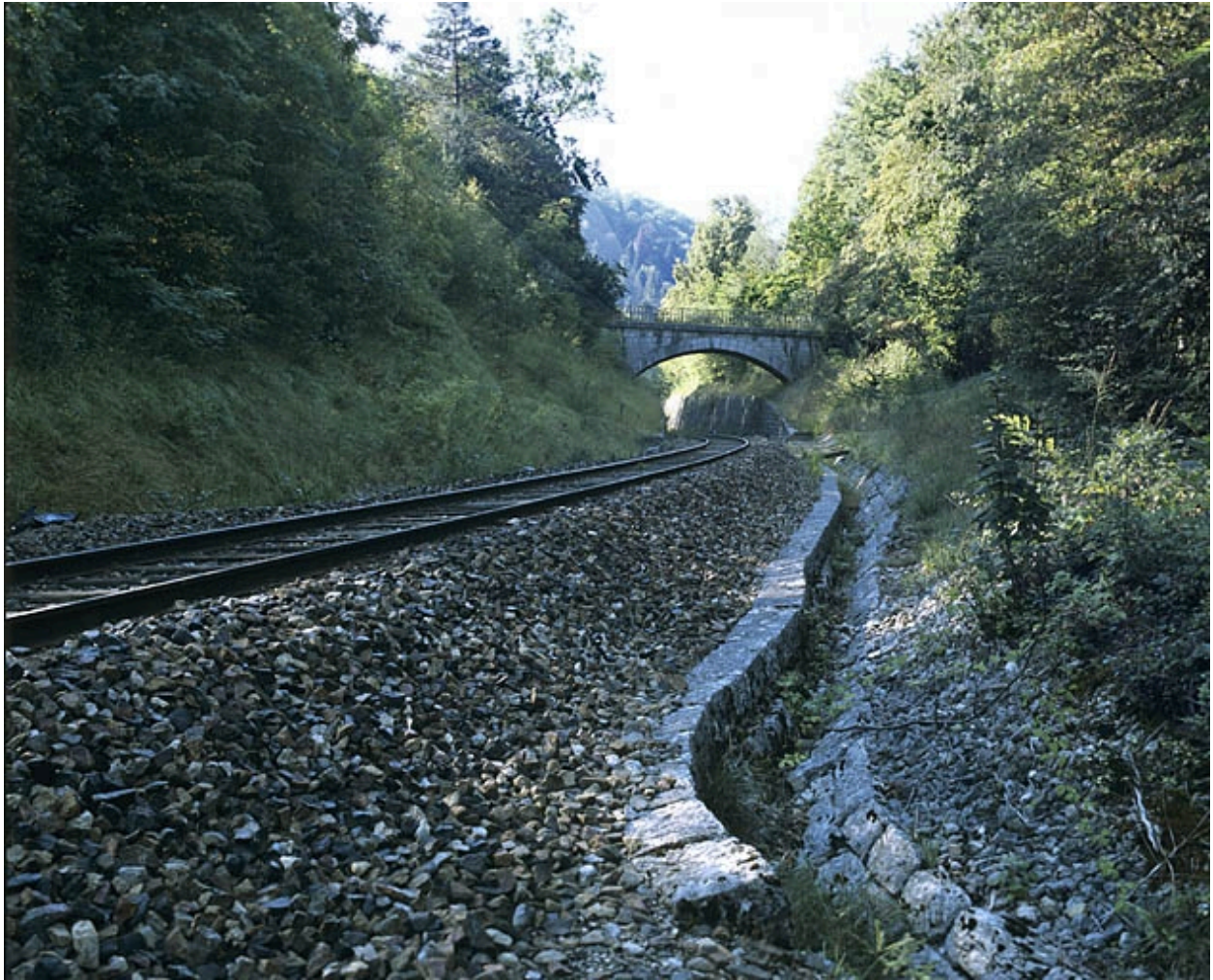
Vue d'ensemble, depuis le côté Andelot-en-Montagne (nord).
