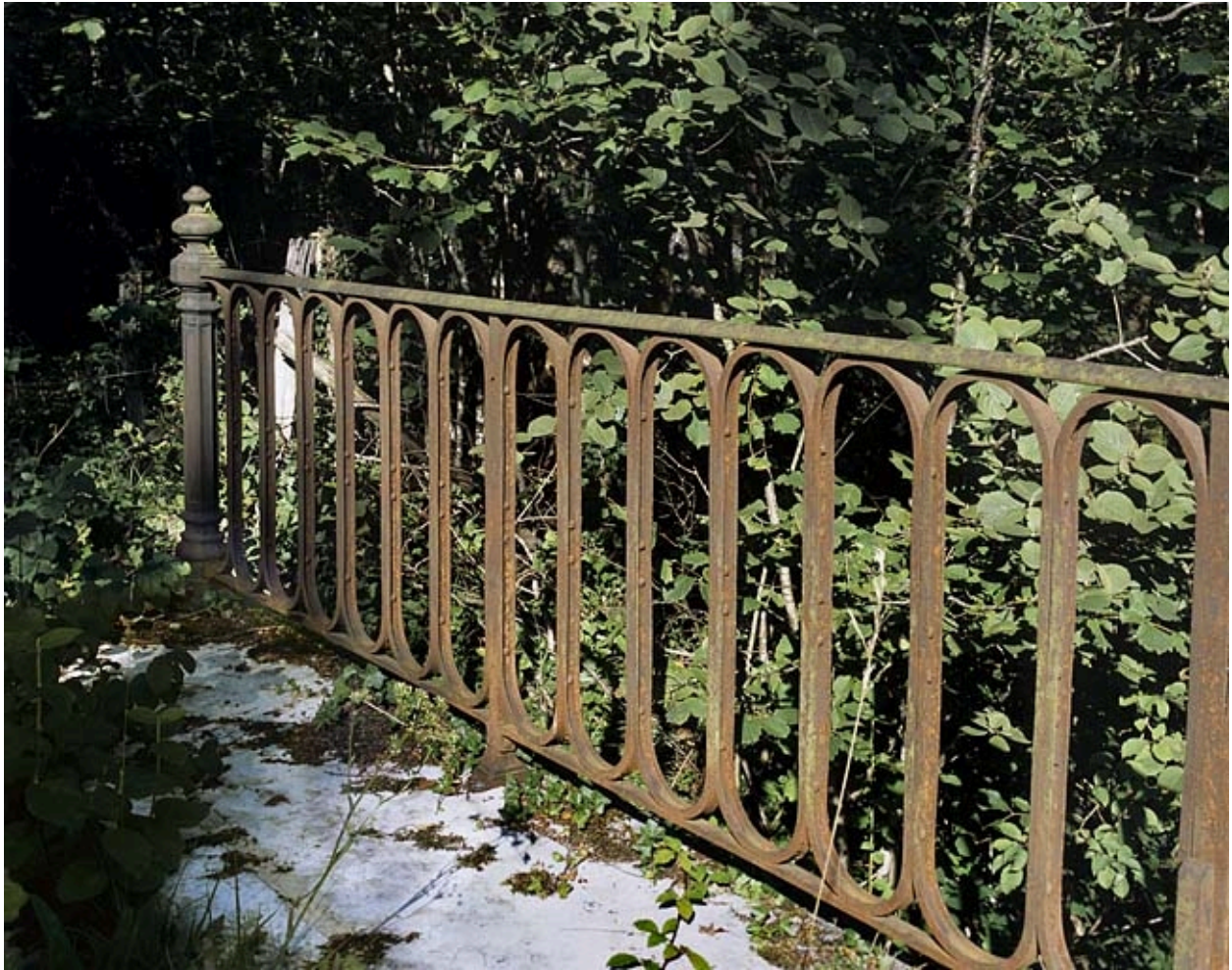
Détail d'un garde-corps.
