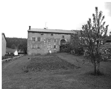
Façade postérieure, vue éloignée.
