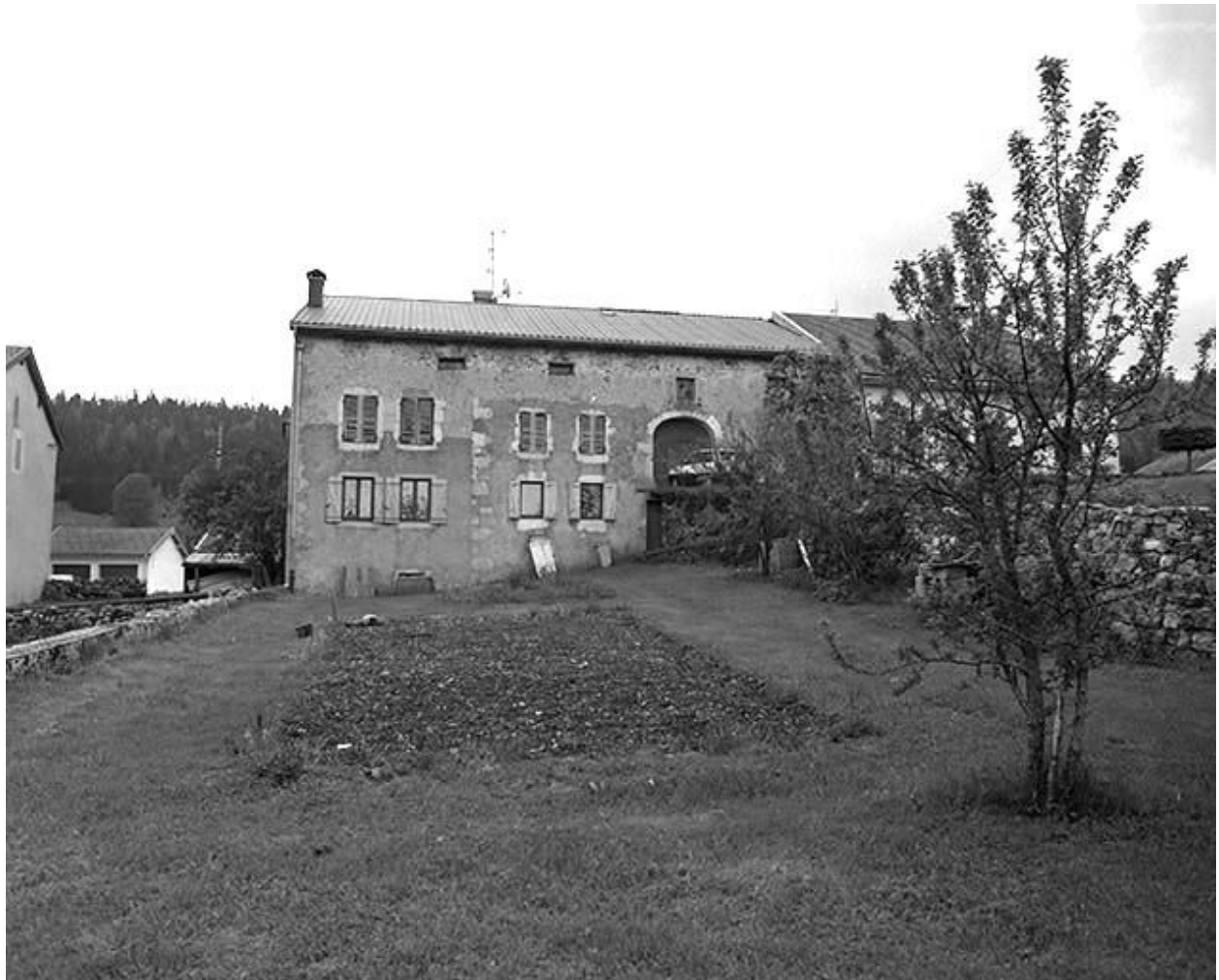
Façade postérieure, vue éloignée.
