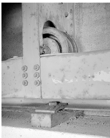
Détail du système de rotation de la coupole : galet. Phot. Jérôme Mongreville IVR43_20032501086X
