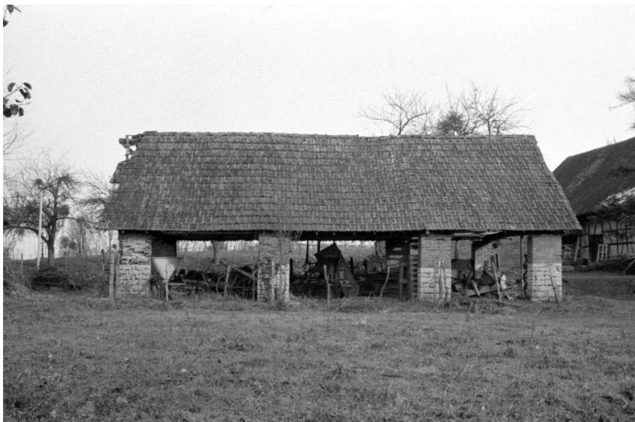
Halle de séchage (D).
