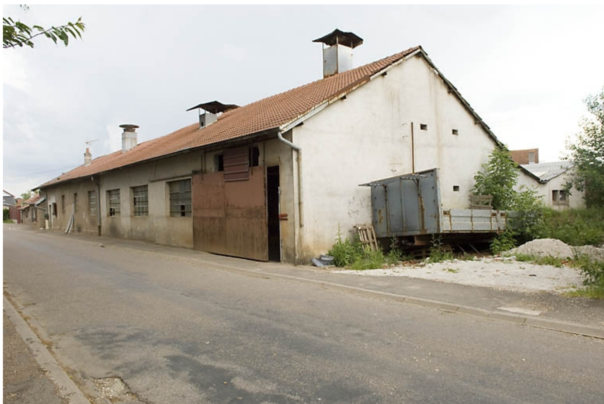
Vue d'ensemble depuis le sud.
