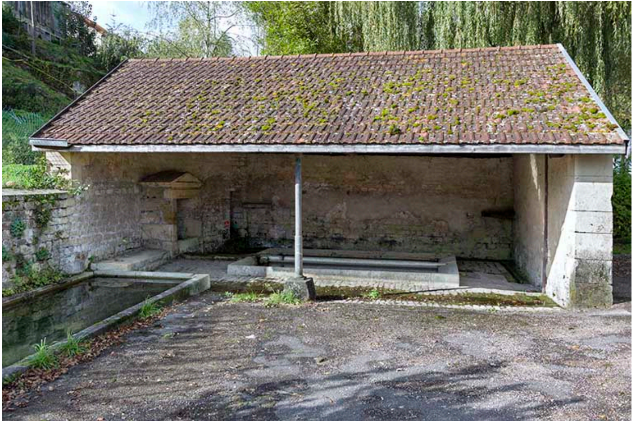
Vue générale de la fontaine-lavoir.
