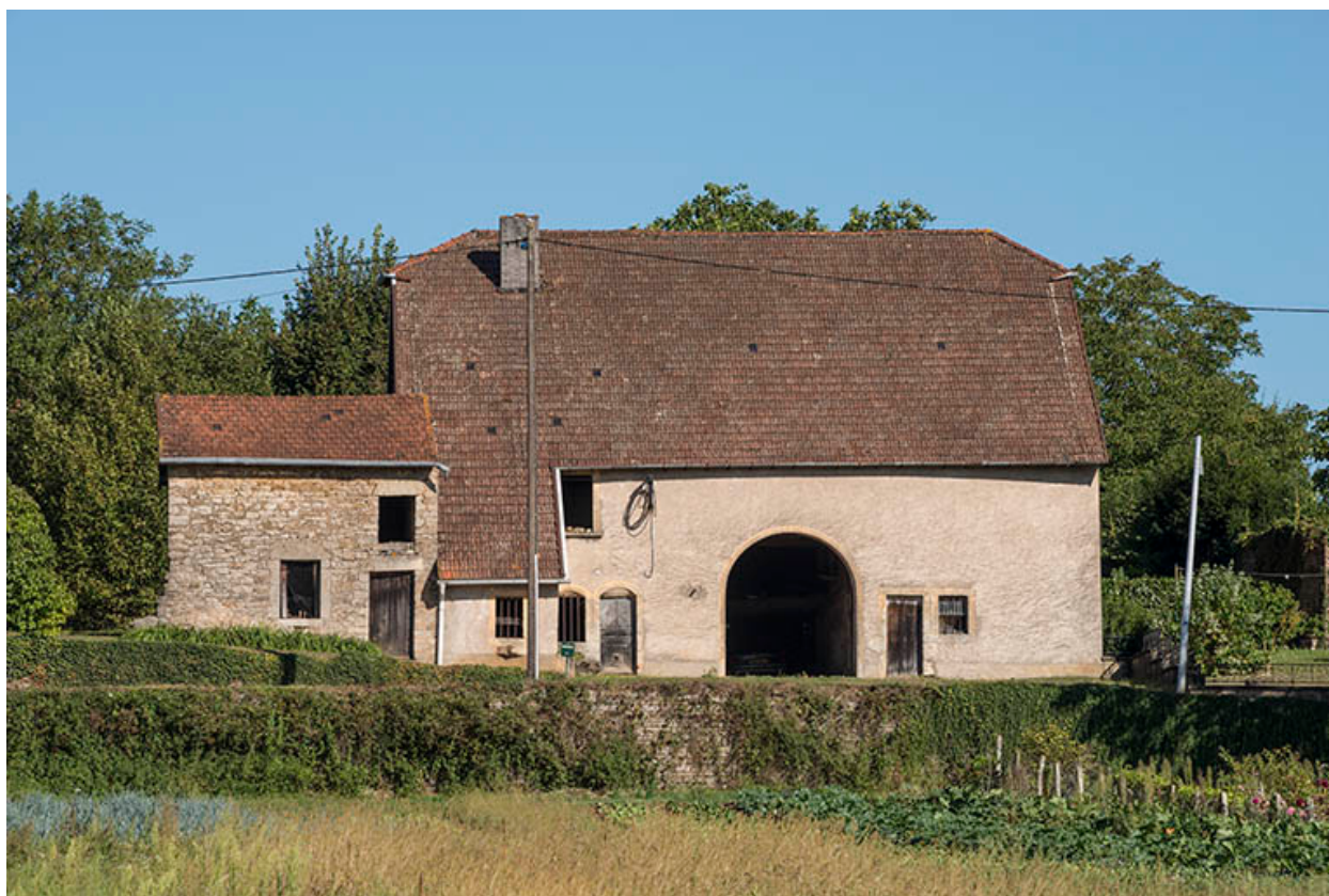
Vue depuis le chemin de la Charrière.
