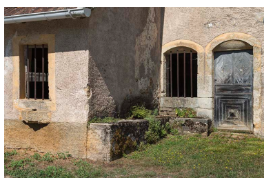
La partie habitation. Phot. Jérôme Mongreville IVR43_20177001210NUC4A
