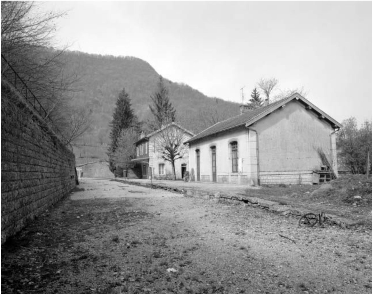
Lods, vue générale des bâtiments de la gare depuis la voie ferrée.
