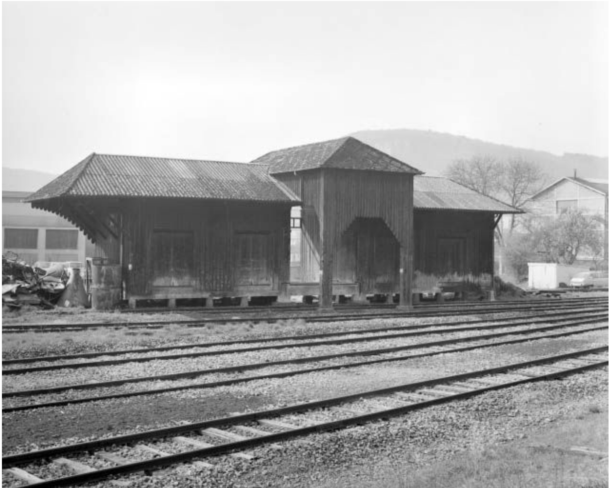
Ornans, façade postérieure de de la gare de marchandises.
