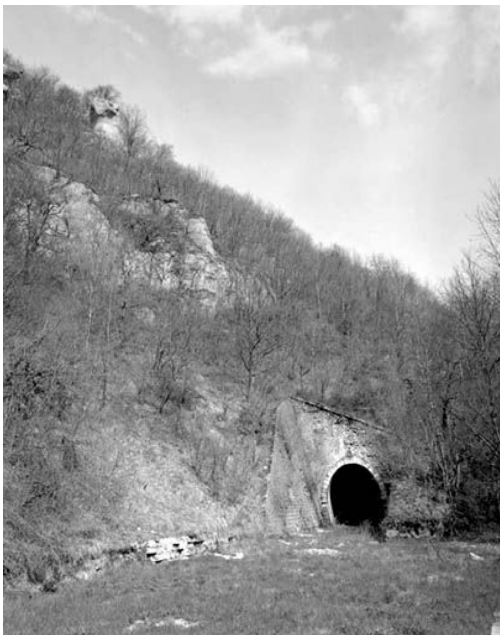
Bonnevaux-le-Prieuré : le tunnel.
