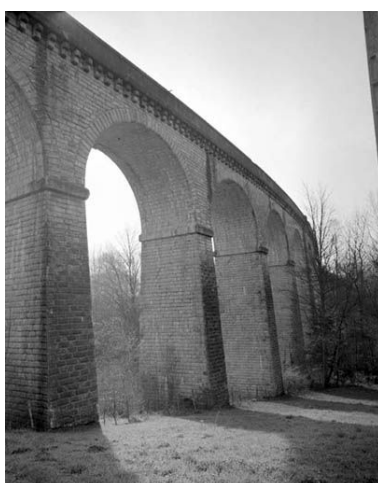
Les piliers du viaduc sur la commune de Scey-Maisières. Phot. Yves Sancey IVR43_19812500213X
