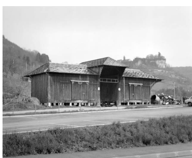
Ornans, façade côté quai de la gare de marchandises. Phot. Yves Sancey IVR43_19812500218X
