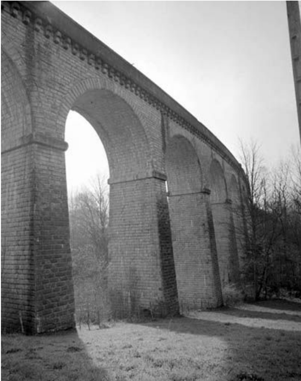
Les piliers du viaduc sur la commune de Scey-Maisières.
