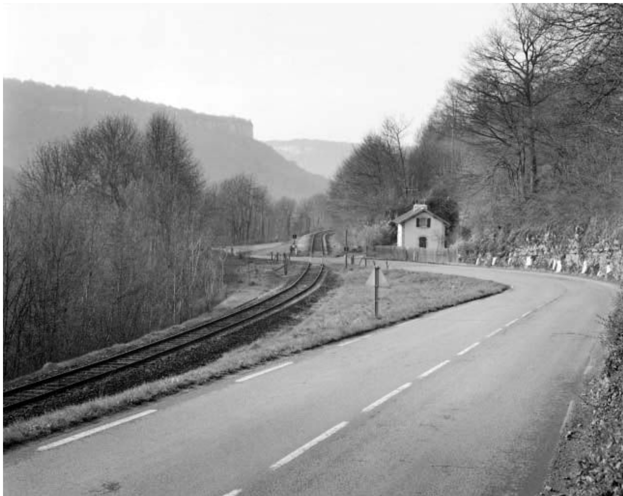
Maison de garde-barrière en bordure de la RD 67, au niveau du Puit Noir, sur la commune de Scey-Maisières.
