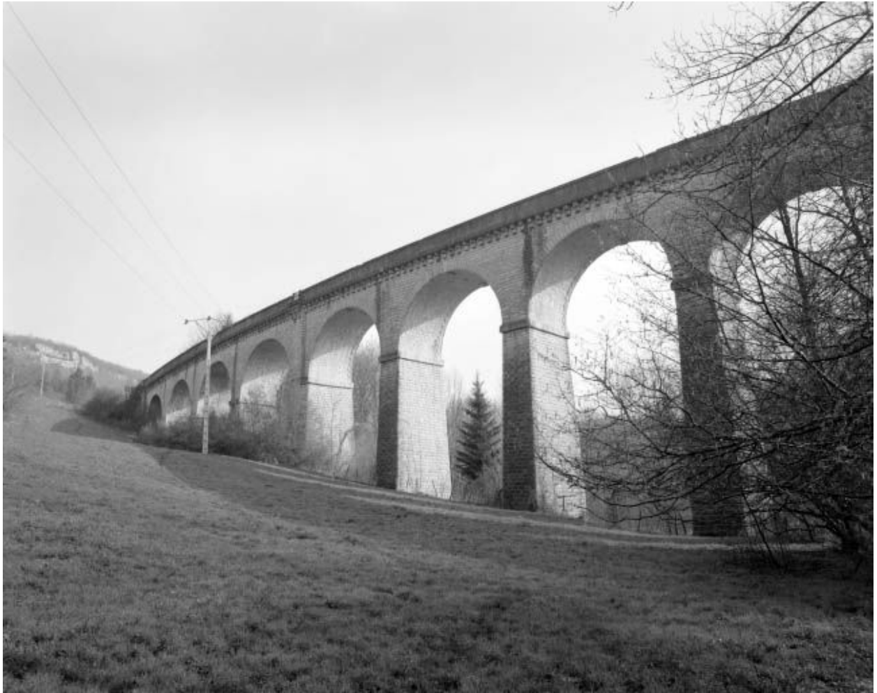
Vue générale du viaduc sur la commune de Scey-Maisières.
