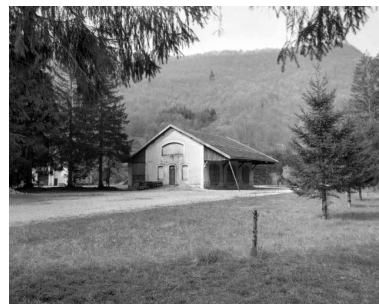
Lods, façade postérieure et façade latérale droite de la gare de marchandises.
