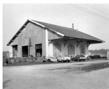
L'Hôpital-du-Grosbois : la gare de marchandises. Phot. Yves Sancey IVR43_19812500216X
