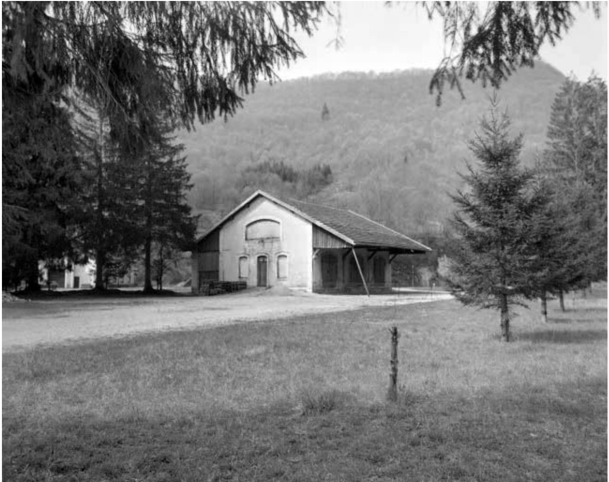
Lods, façade postérieure et façade latérale droite de la gare de marchandises.
