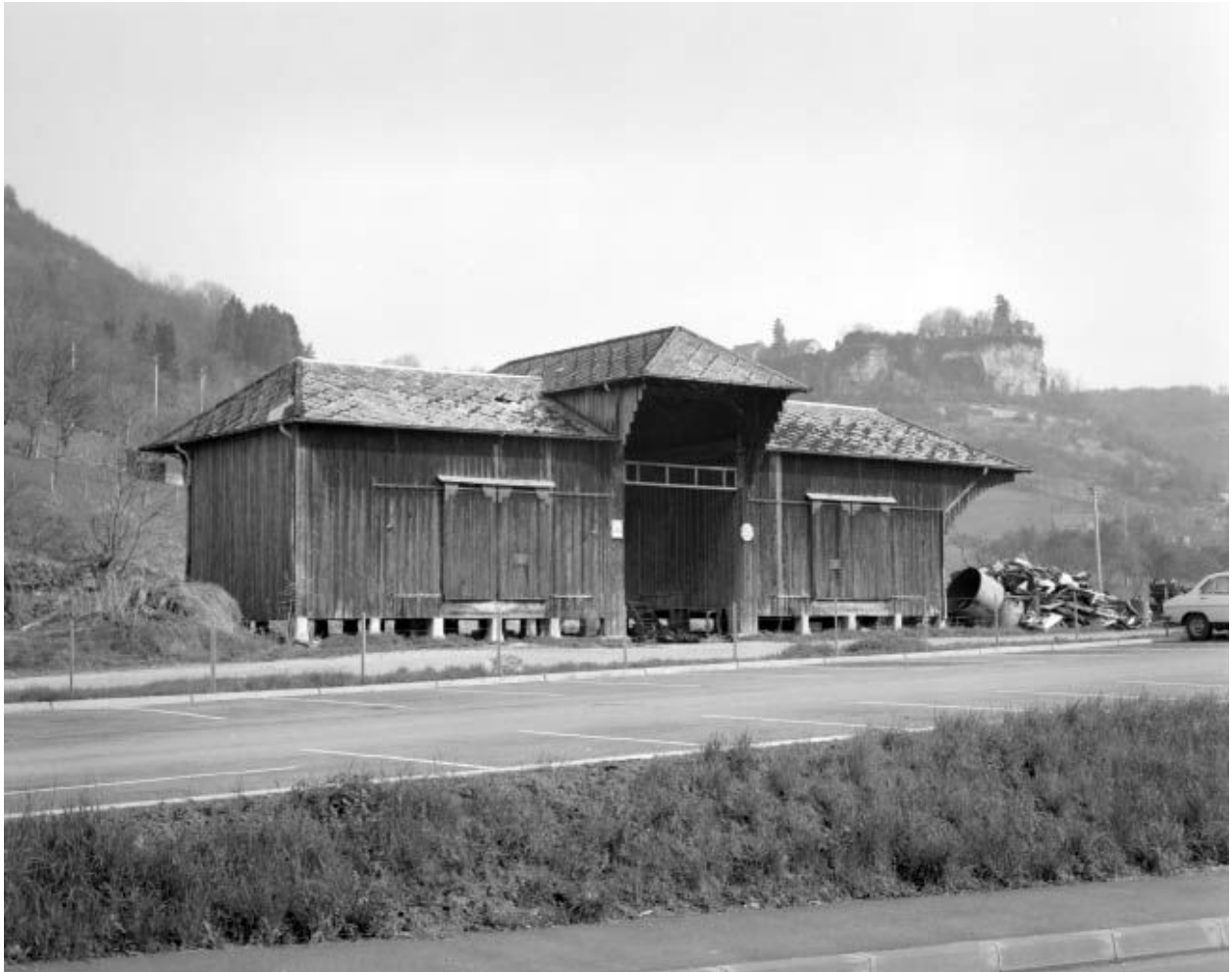
Ornans, façade côté quai de la gare de marchandises.
