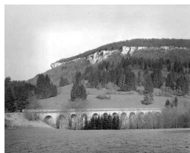
Vue générale du viaduc sur la commune de Scey-Maisières. Phot. Yves Sancey IVR43_19812500210X
