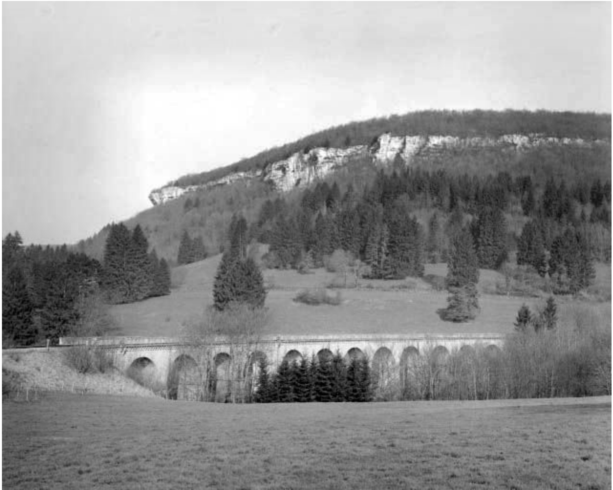
Vue générale du viaduc sur la commune de Scey-Maisières.
