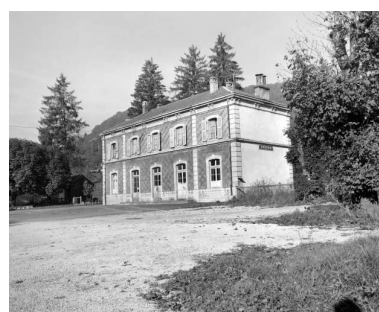
Ornans, façade antérieure de la gare de voyageurs. Phot. Yves Sancey IVR43_19812500527X
