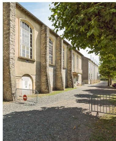
Vue des contreforts.
