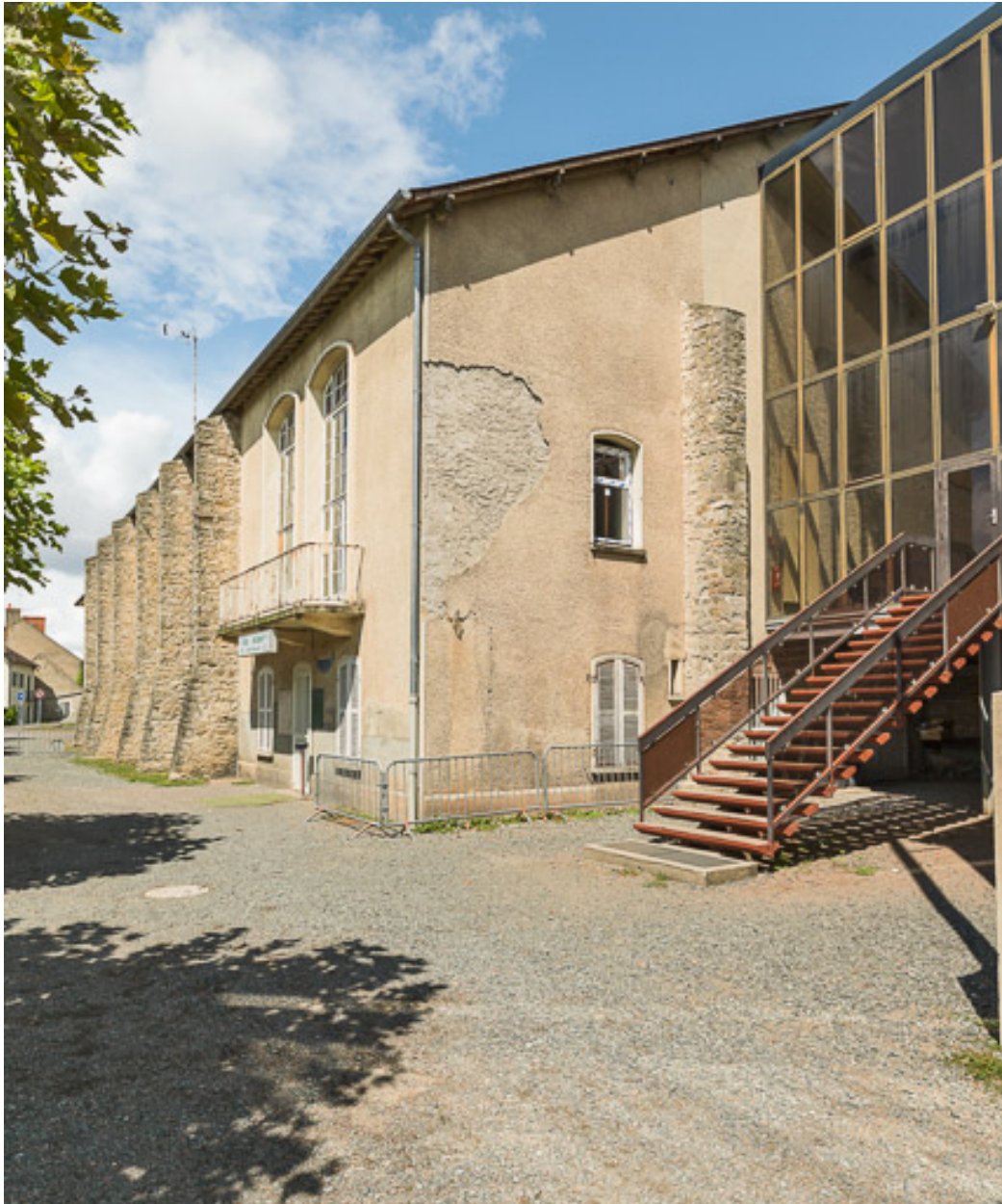
Vue du bâtiment et des contreforts.
