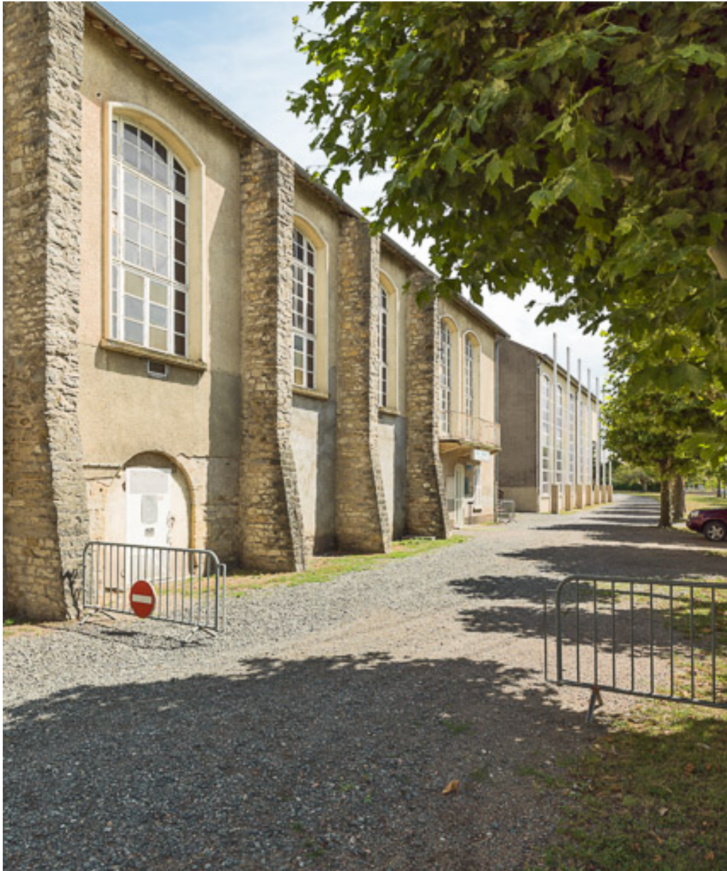
Vue des contreforts.
