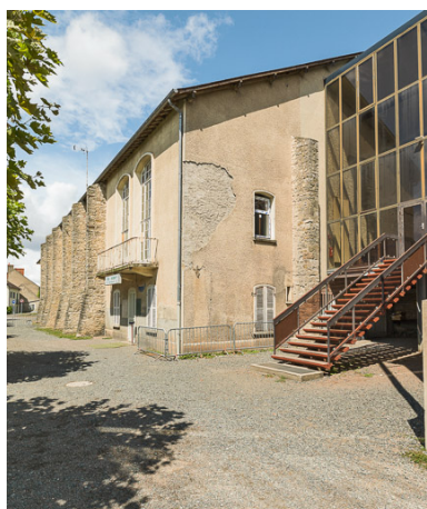
Vue du bâtiment et des contreforts.
