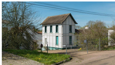
Détail d'un bâtiment de l'entre-deux-guerres.
