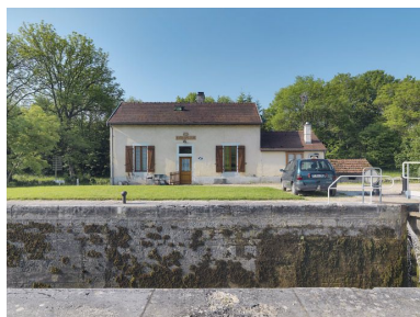
La maison éclusière de face. Phot. Thierry Kuntz IVR26_20122102312NUC4A
