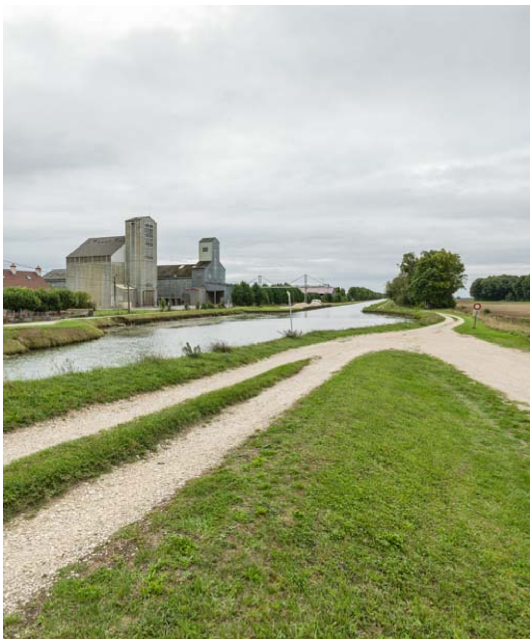
Vue d'ensemble de la gare d'eau.
