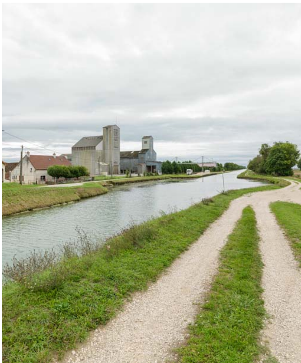
Vue d'ensemble de la gare d'eau.
