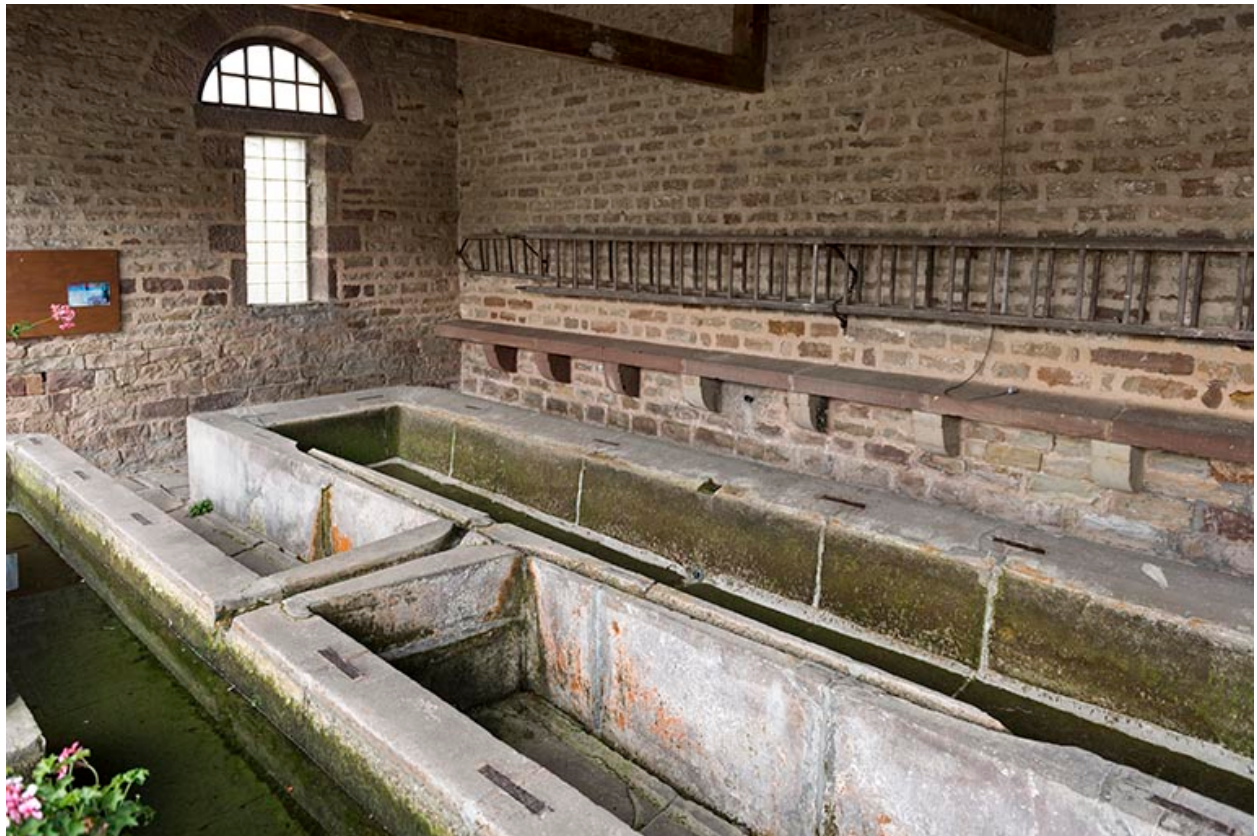
Bassins du lavoir.
