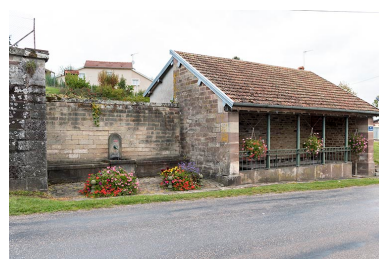
Fontaine-lavoir, rue de la Tuilerie.
