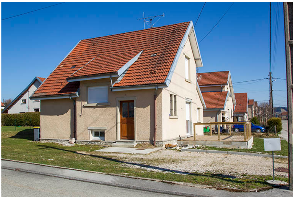
Façades latérale gauche et antérieure.
