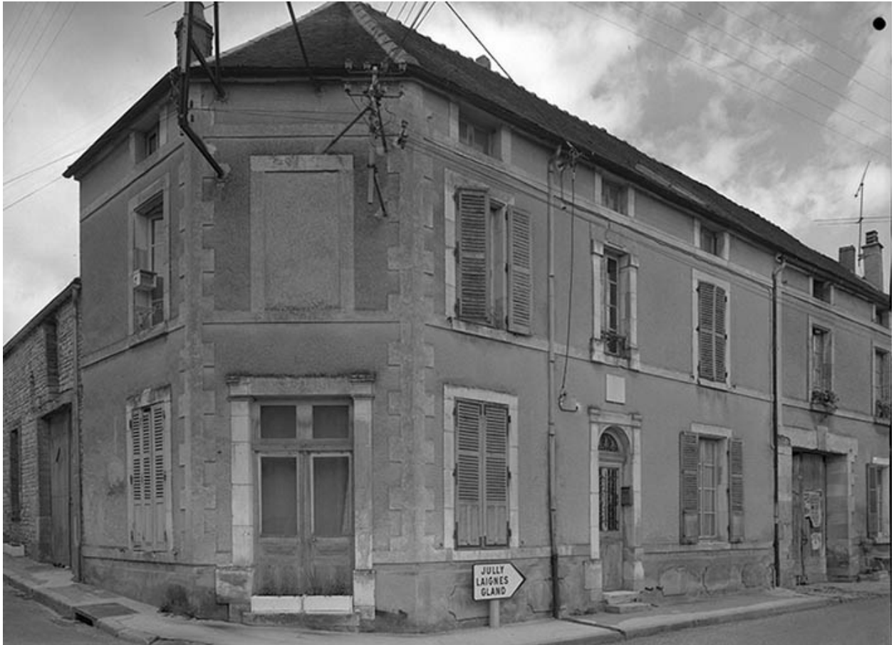
Façades sur rues.
